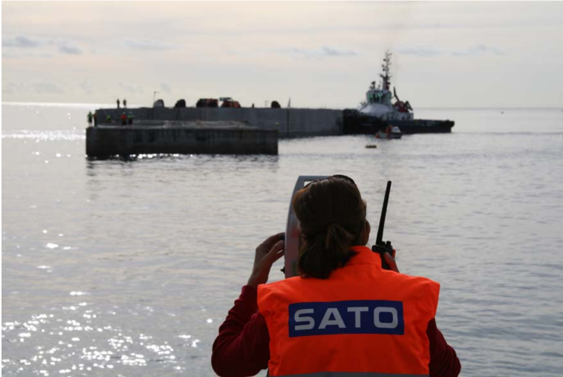
Imagen 19: Comprobación topográfica de la situación del cajón.
