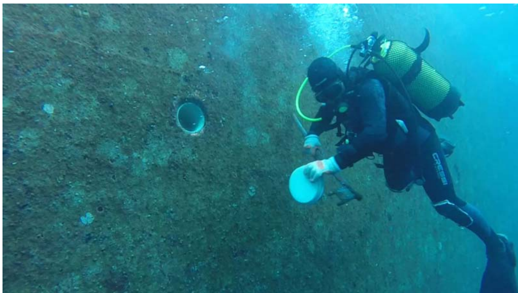
Imagen 4: Apertura de válvulas en cajón.
