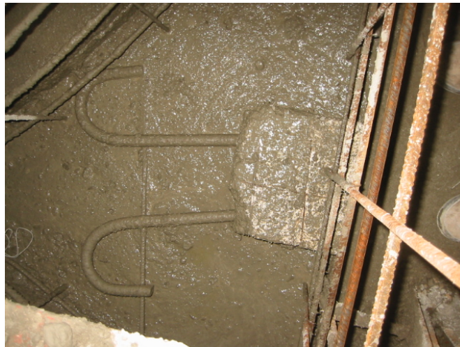
Imagen 8: Detalle ganchos dentro del cajón
