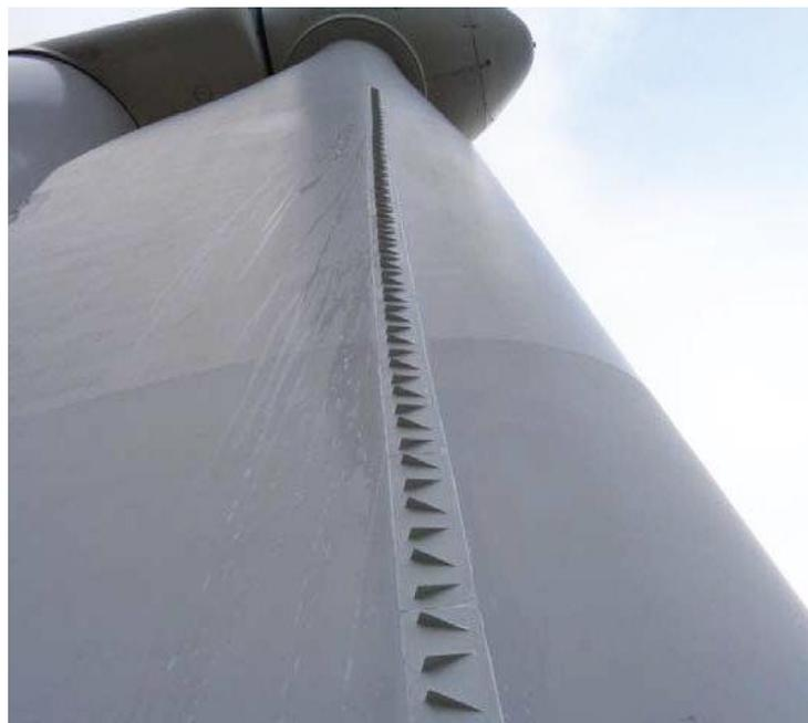
Figura 2.11. Generadores de vórtices en la pala de un aerogenerador.
