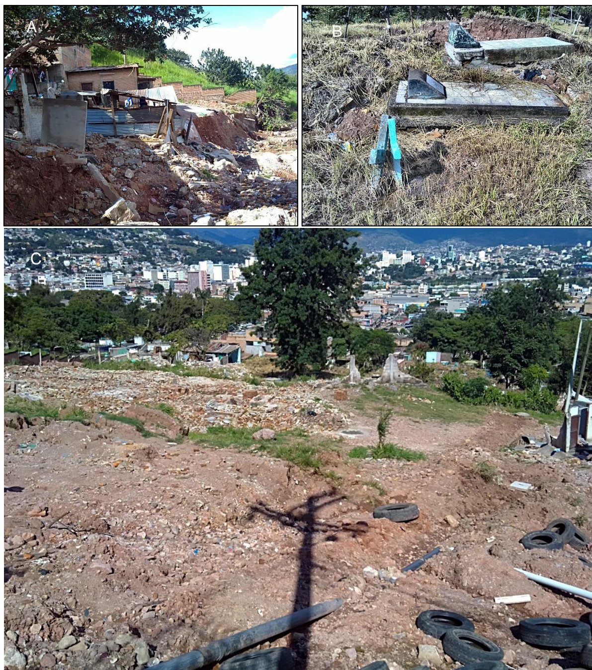
Figura 76. Deslizamientos en la colonia La Obrera. A. Escarpe correspondiente a la corona en la cabecera del deslizamiento. B. Desplazamiento de tumbas en el pie del deslizamiento. C. Vista general de la zona deslizada con escombros de las casas destruidas. Fotos propias, septiembre 2010.
