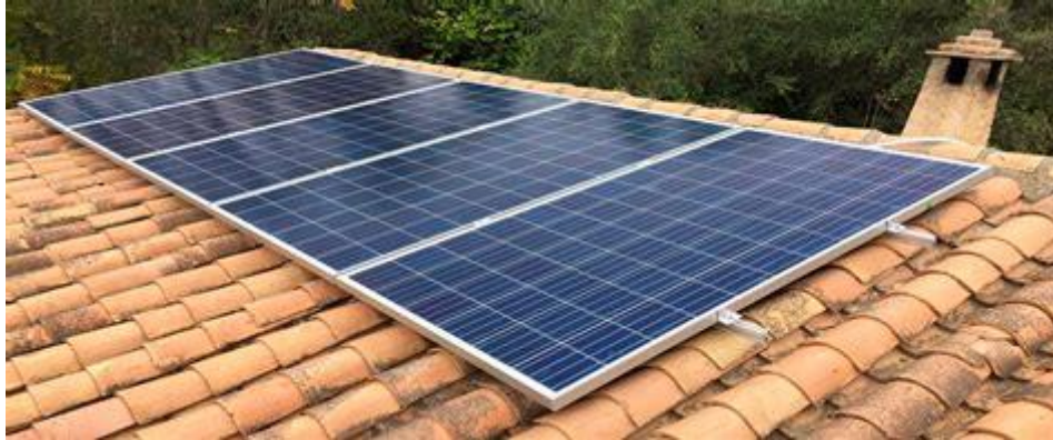
Figura 2.17.- Paneles solares dispuestos en superposición [20].
