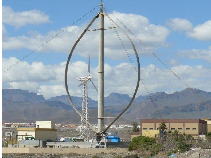
Figura 6.3.- Aerogenerador de eje vertical tipo DARRIEUS [51].
