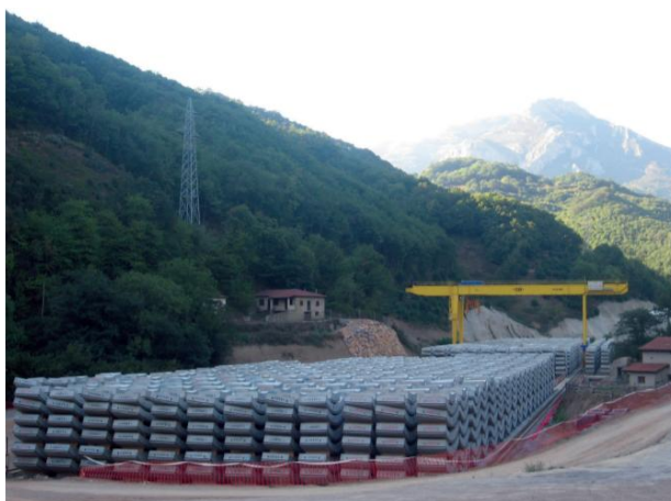
Fig. 28 Detalle del acopio de dovelas del emboquille norte
