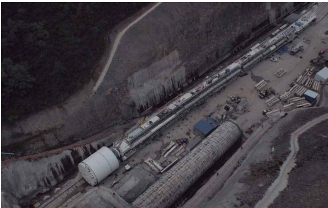
Fig. 43 Detalle de la TBM fuera del túnel
