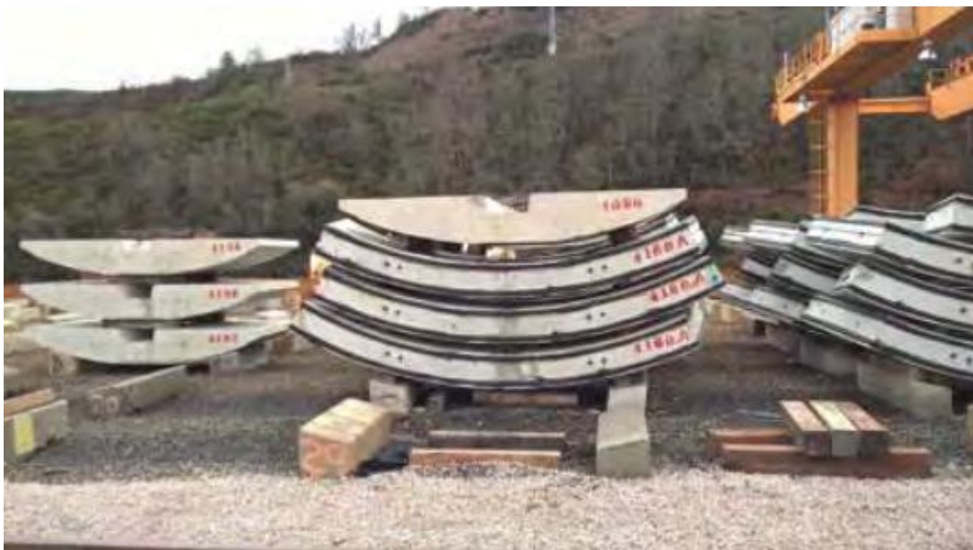
Fig. 44 Detalle de dovelas en el parque (calleja 2017)
