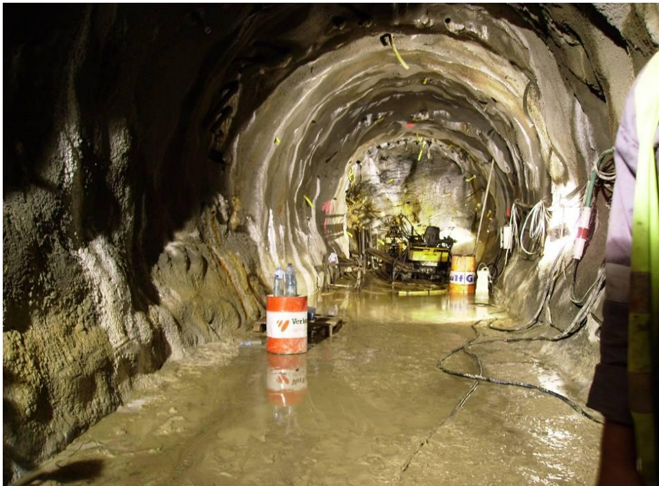
Fig. 19 Sondeos horizontales realizados desde la galería piloto.
