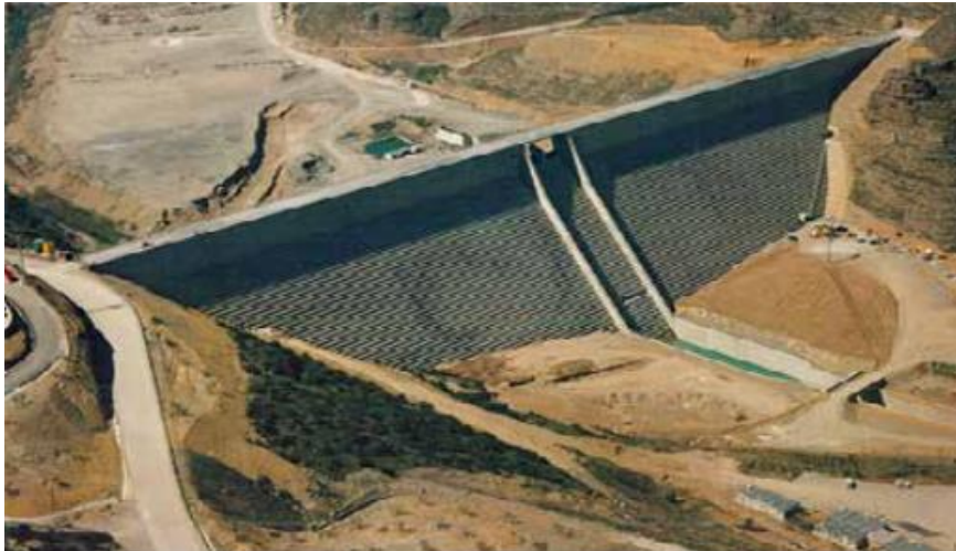
Figura 5. Presa de hormigón por gravedad. Fuente: Sandoval (2018).
