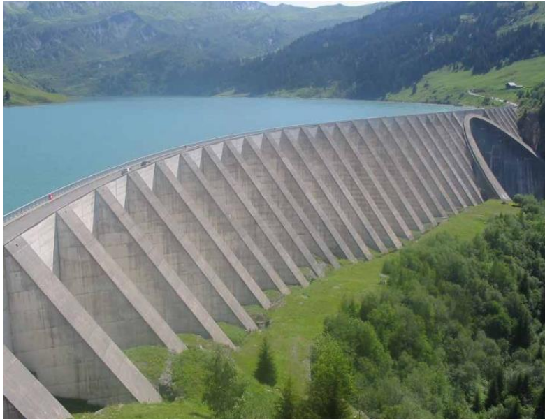
Figura 7. Presa de hormigón de contrafuertes. Fuente: Sandoval (2018).
