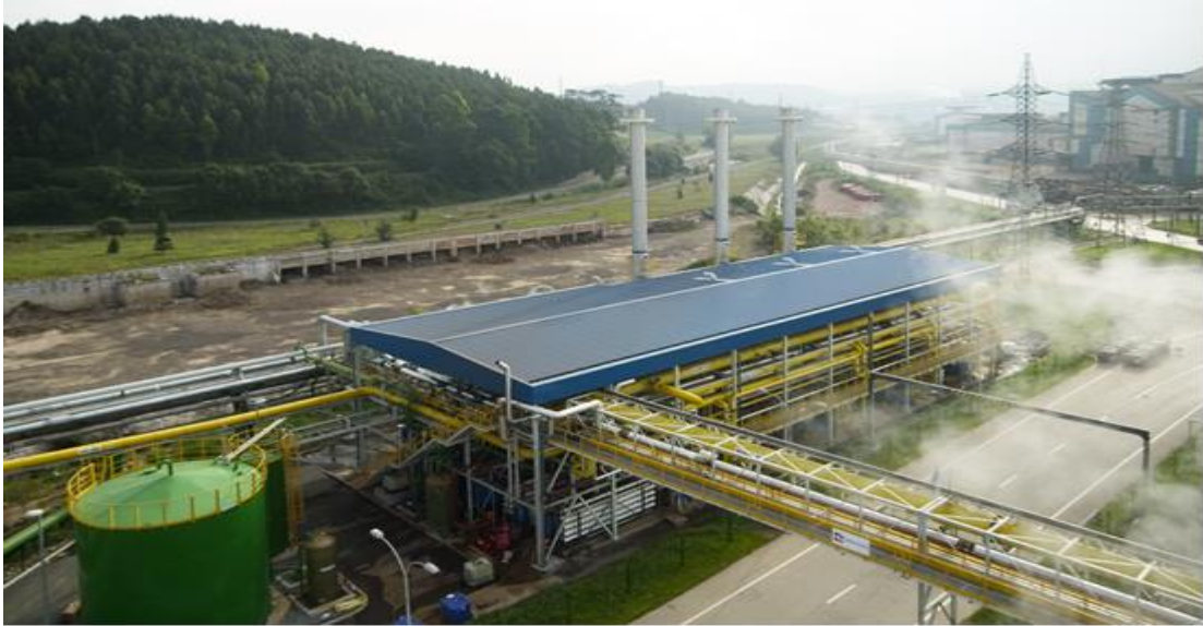
Ilustración 2: Vista general Planta Térmica
