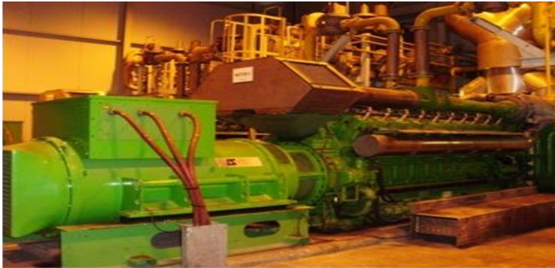
Ilustración 5: Vista grupo motogenerador
