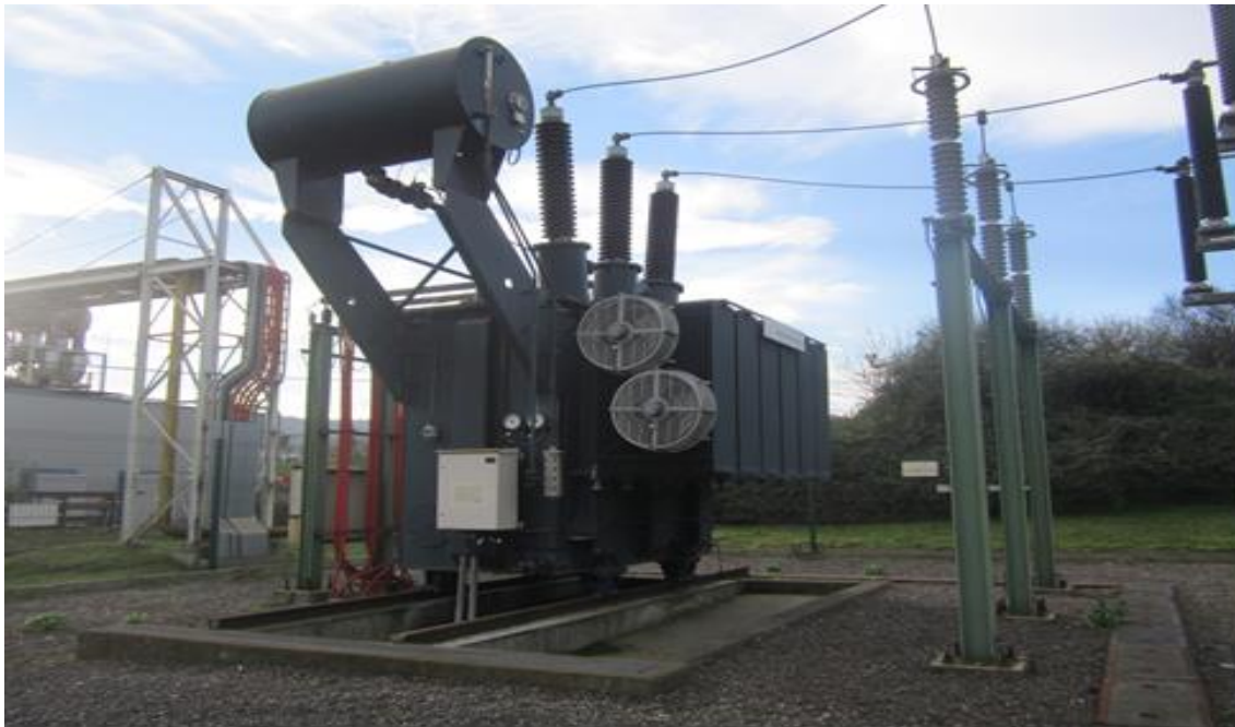
Ilustración 6; Transformador principal 10.5 a 132 kV
