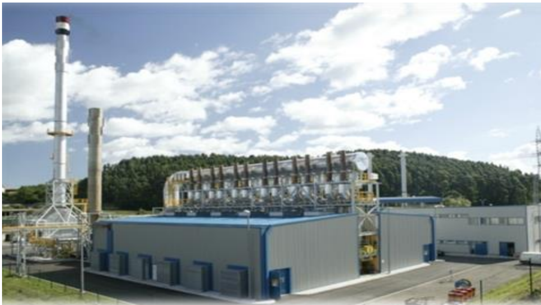
Ilustración 4: Vista general Planta Eléctrica
