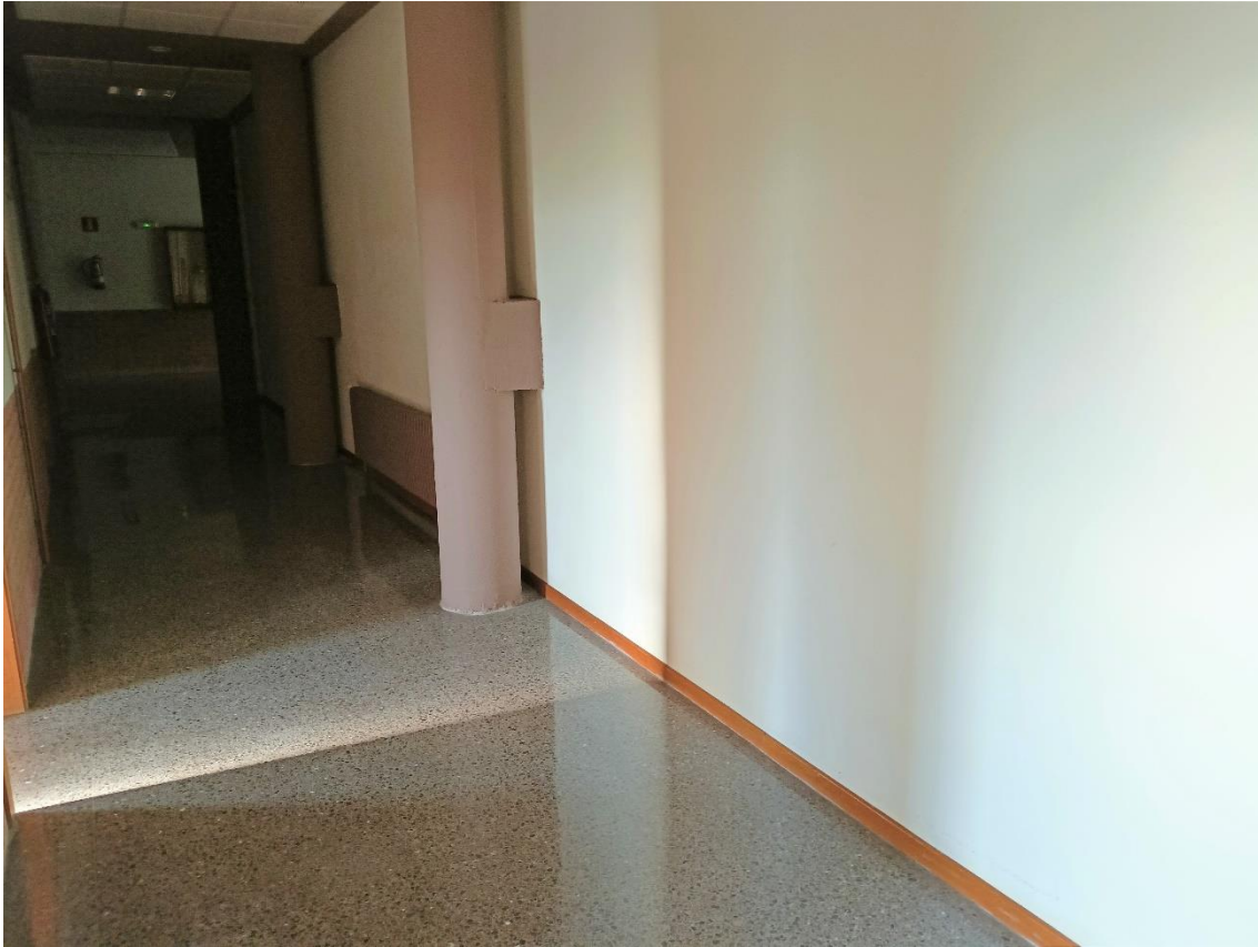
Ilustración 7.17. Fotografía radiadores planta Baja
