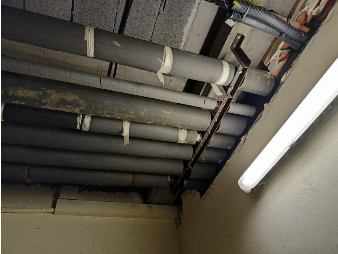
Ilustración 7.14. Fotografía líneas generales planta sótano
