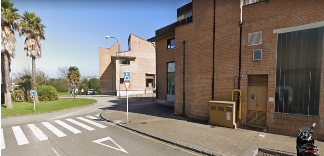
Ilustración 7.12. Imagen obtenida con Google Earth de la sala de calderas
