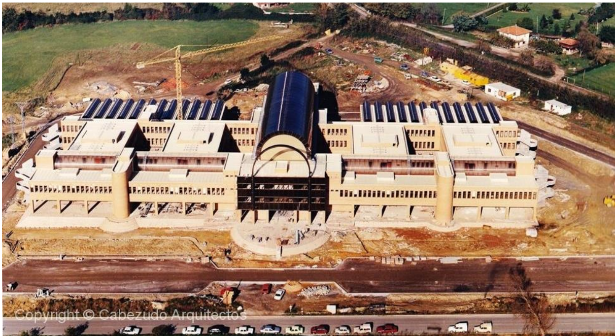
Ilustración 7.3. Edificio durante su construcción.
