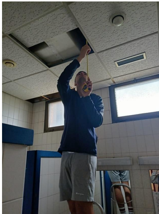
Ilustración 7.65. Mediciones de los Falsos Techos.
