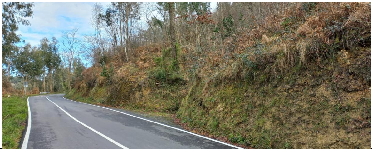
Vista general del talud E a inicio. Cuneta de pie discontinua a lo largo del talud con un entrante en la parte central.
