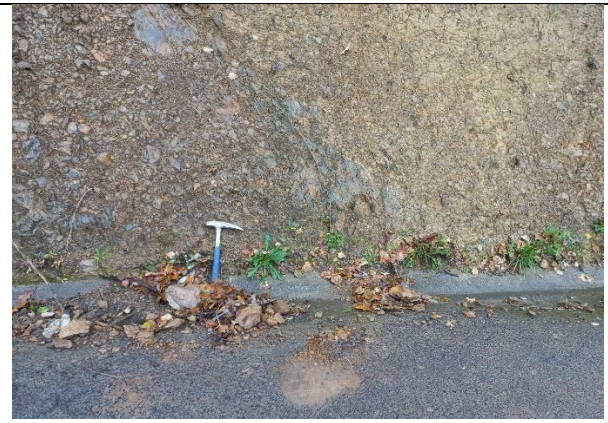
Detalle de material acumulado en la cuneta de pie.
