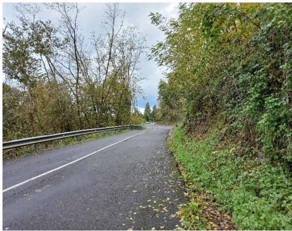
Detalle del trazado, sinuoso y con hundimientos recurrentes. Cuneta de drenaje obstruida.
