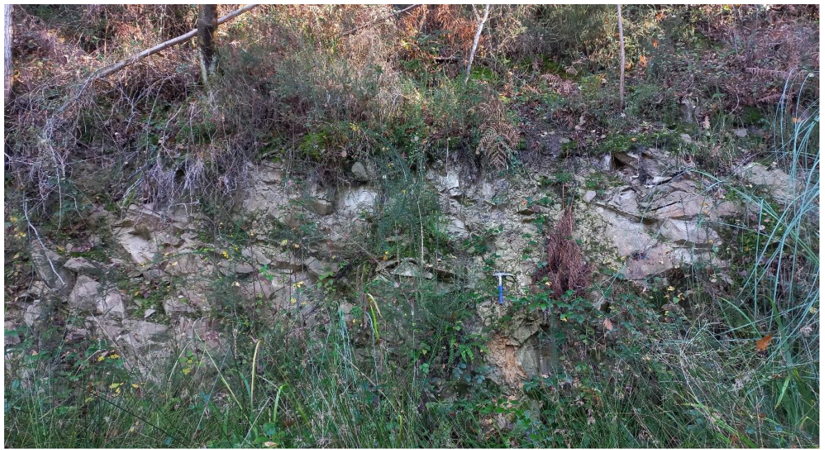
Vista del afloramiento rocoso del talud en el PL 24.
