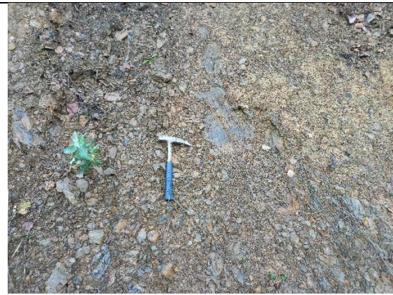
Detalle de la superficie de rotura planar en PK 0+510
