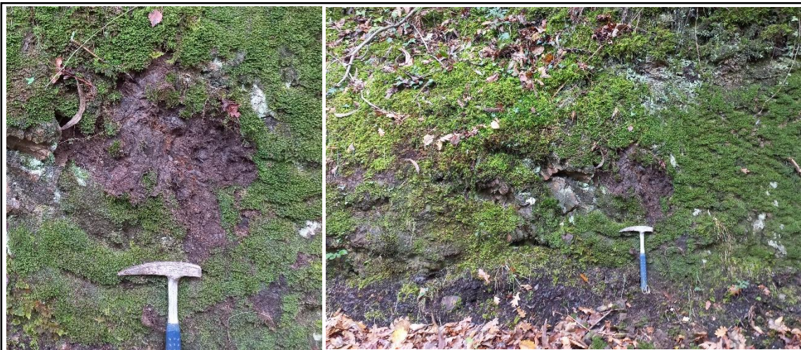
Figura 4.6. Detalle de suelos arcillosos blandos con abundante materia orgánica y humedad.
