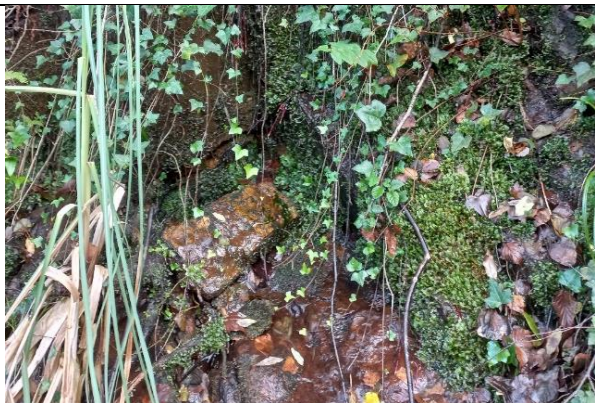
Detalle de las areniscas del PL 18 donde se observa un manantial en el PK 1+450.
