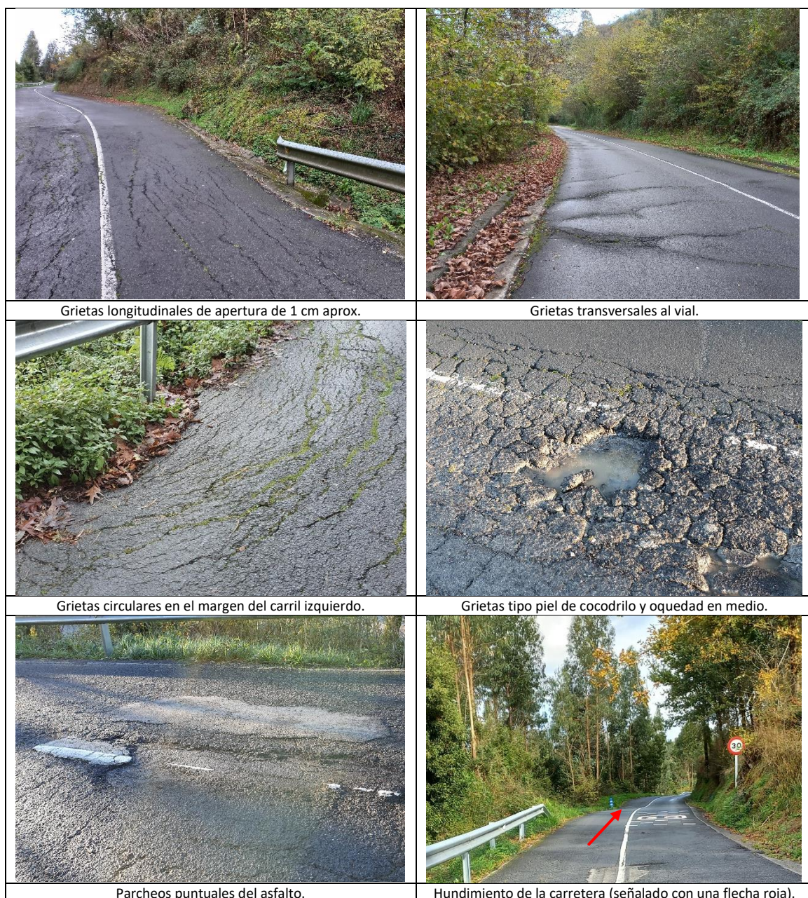
Figura 4.14. Imágenes de las diferentes patologías observadas a lo largo del trazado.
