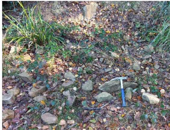
Detalle de bloques decimétricos acumulados a pie de talud.
