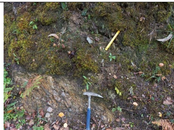
Grieta en afloramiento con apertura de hasta 2 cm en PK 0+350.
