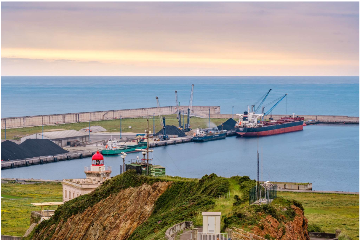
Imagen 29 - Fotografía que muestra la actividad que se desarrolla actualmente en el nuevo Muelle Norte. La descarga de buques de diversos portes por parte de operadores privados utilizando grúas móviles representa una imagen muy diferente al proyecto de una gran terminal especializada en descarga de graneles que estaba previsto inicialmente. Fuente: Tomás Fano
