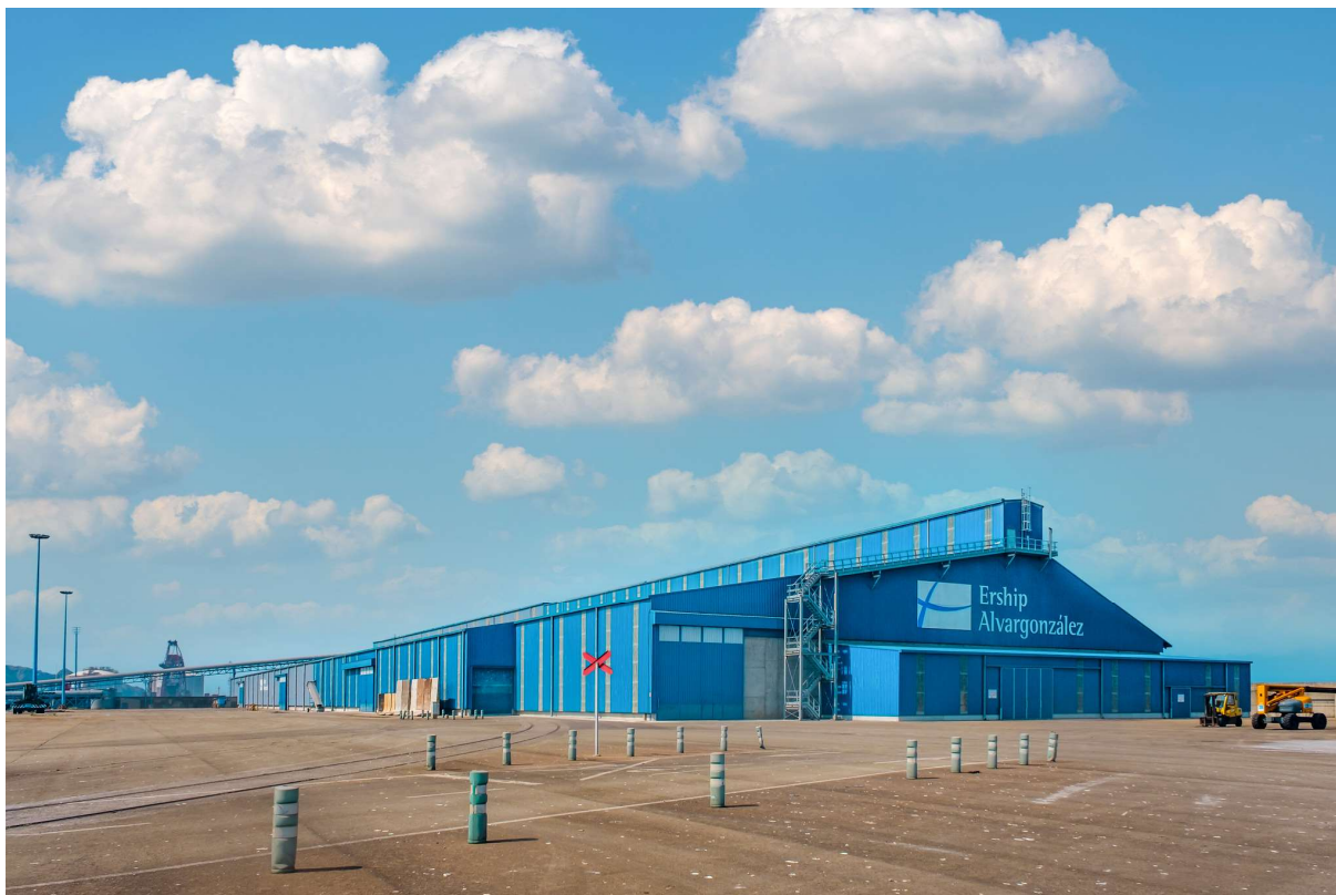
Imagen 26 - Nueva instalación de recepción y distribución de cereales instalada en el terreno ganado al mar tras la ampliación del muelle Moliner. Fuente: Tomás Fano
