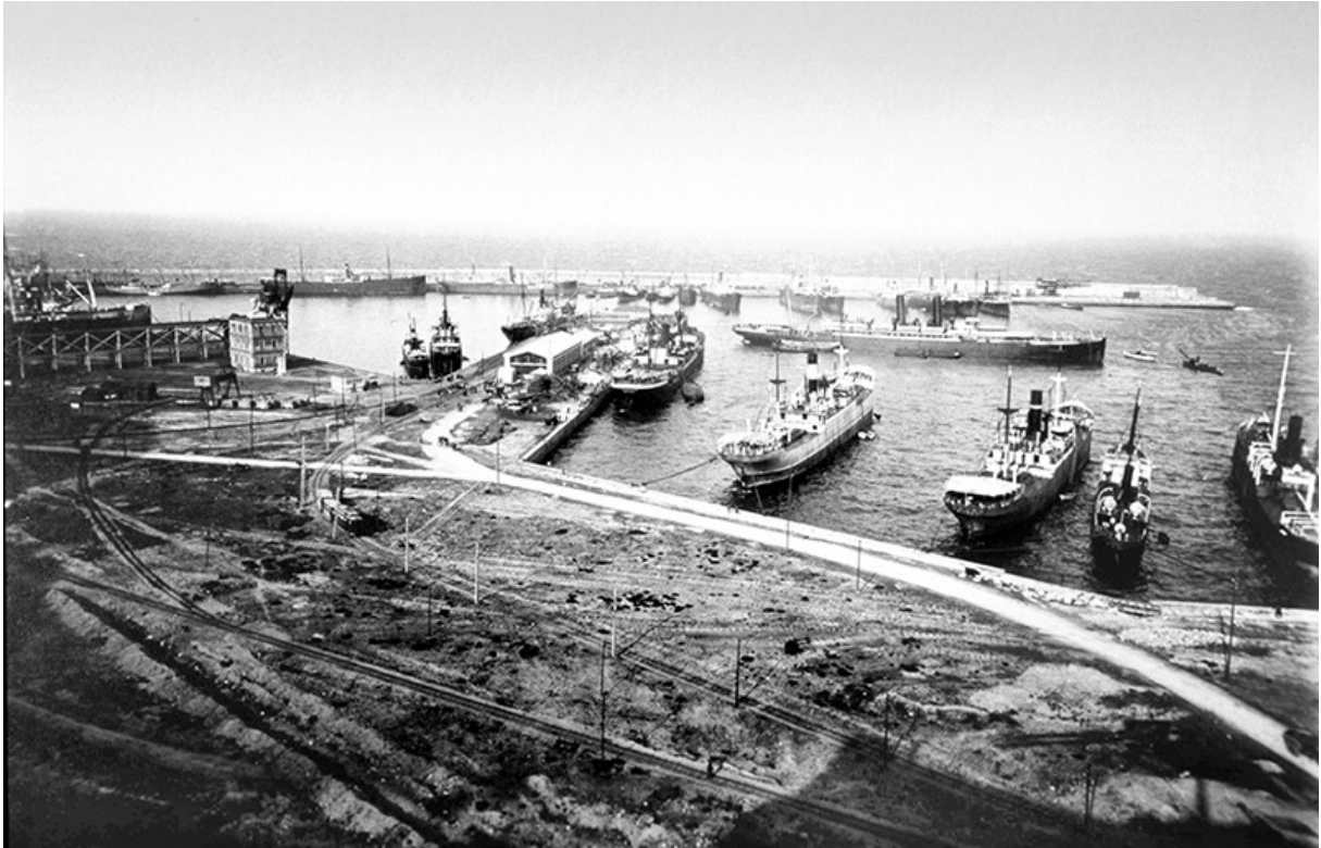
Imagen 3 - Fotografía que muestra un aspecto general del puerto del Musel en sus orígenes, en torno a la primera década del siglo XX. La actividad exportadora de carbón queda patente al observar a la izquierda el cargadero de vagones en los Muelles de Ribera. Fuente: Página de la Autoridad Portuaria de Gijón.
