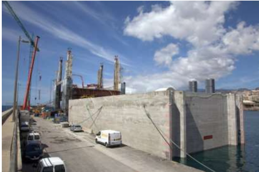
Imagen 28 – Operación de puesta a flote de un cajón de hormigón producido en el buque cajonero Tarifa Primero. Fuente: delacontecerportuario.wordpress.com
