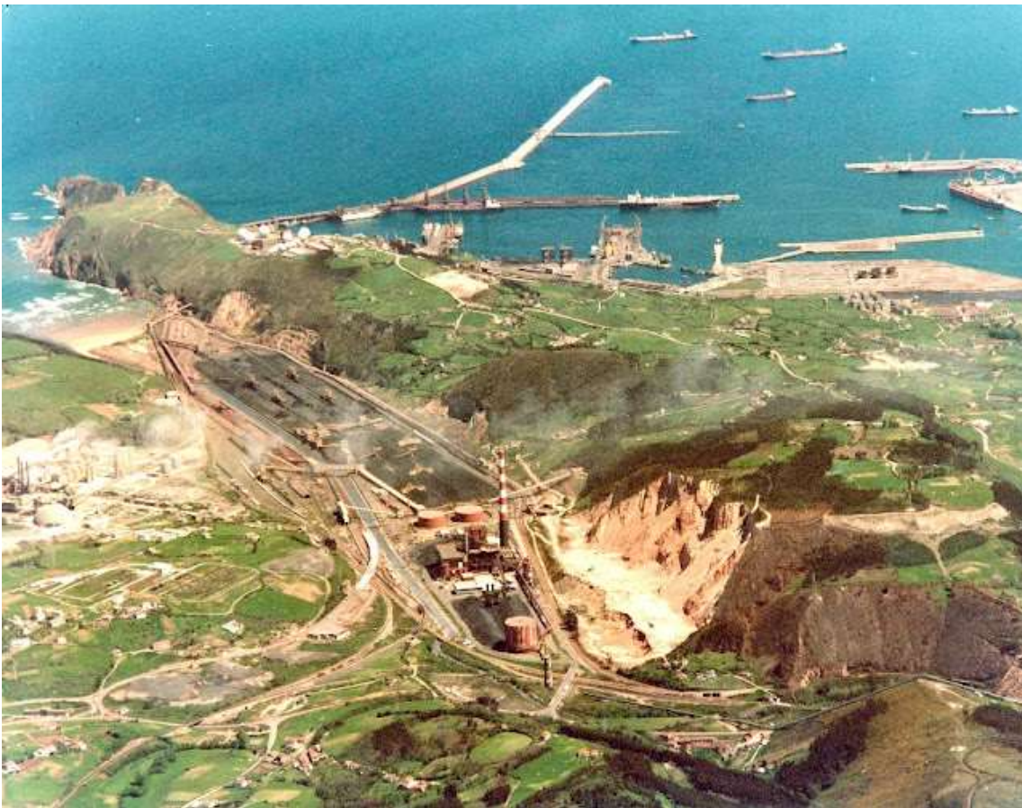
Imagen 11 - Curiosa imagen aérea tomada en 1978. Destacan, en primer lugar, la playa de Aboño a la izquierda en su estado original, los procesos de construcción del nuevo Dique Príncipe de Asturias en el centro y las obras en ejecución del muelle pesquero del Rendiello y la futura terminal de Campsa más a la derecha. Fuente: embolicart.blogspot.com
