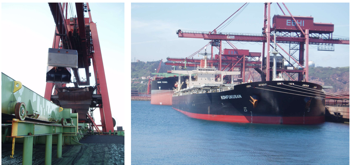
Imagen 16 - Detalles de las grúas pórtico y operaciones de descarga en la terminal E.B.H.I. Fuente: Elaboración propia del autor.
