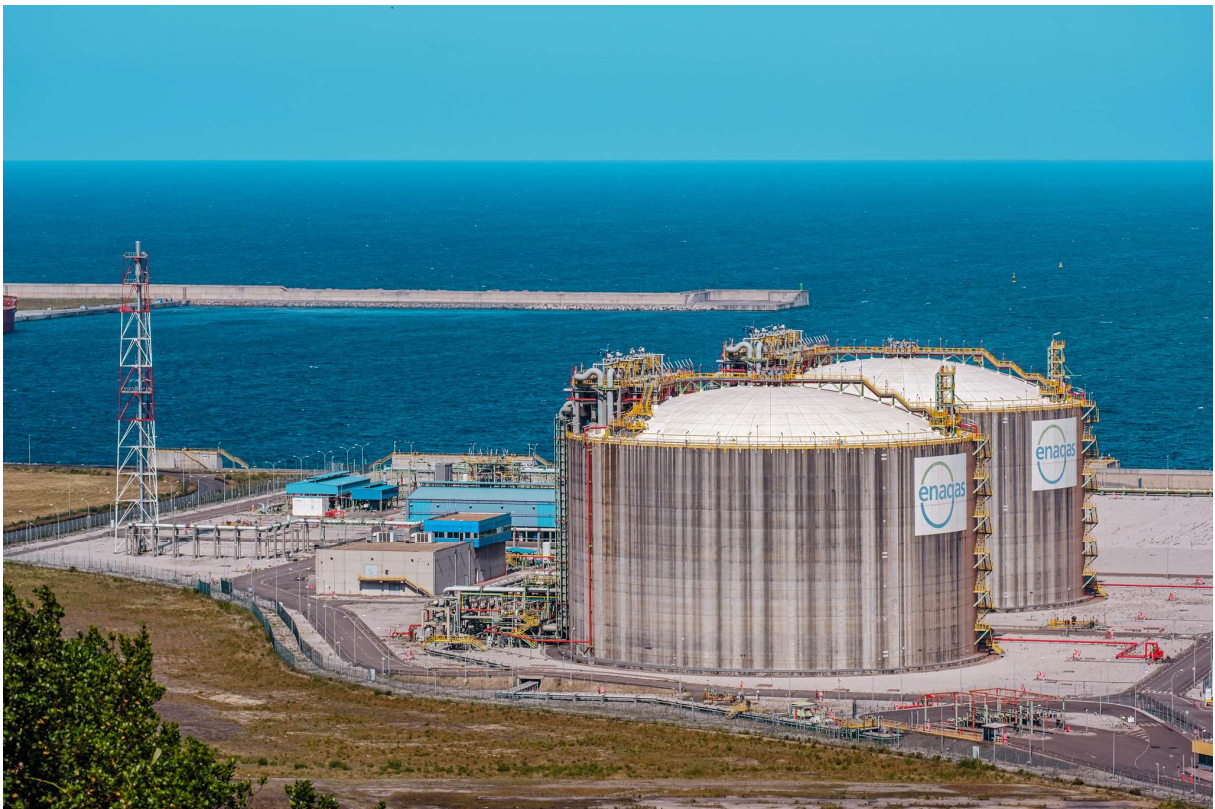
Imagen 33 - Instalaciones de la planta de regasificación de Gijón con sus dos tanques de 150.000 m 3 , instalación que se encuentra en estado de hibernación desde la finalización de su construcción en 2013. Fuente: Tomás Fano
