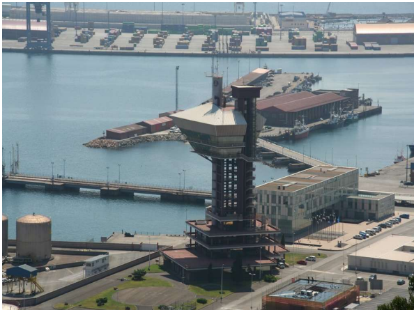
Imagen 19 - Torre de control de tráfico marítimo en el Museo junto al nuevo edificio de la Autoridad Portuaria. Fuente: mapio.net
