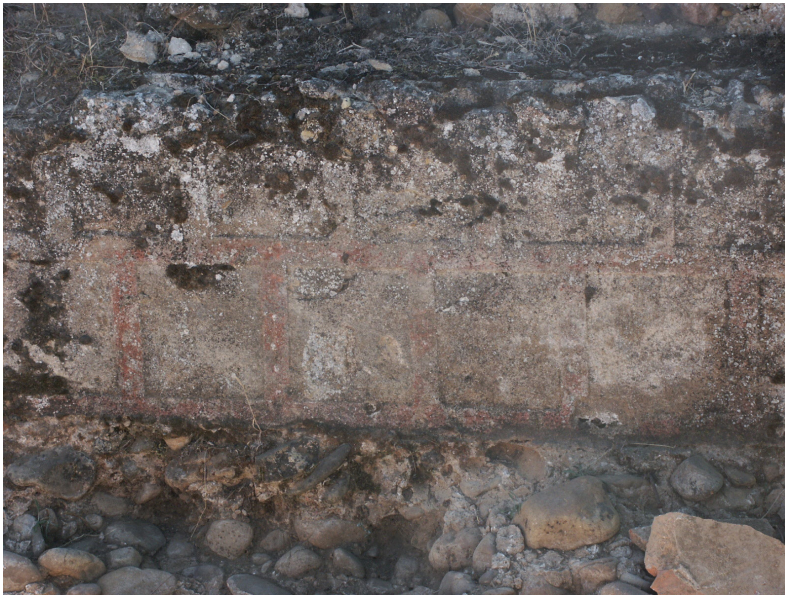
Fig. 4. Detalle de las juntas pintadas en rojo con puntos blancos, simulando sillería (fotografía A. Gutiérrez)
