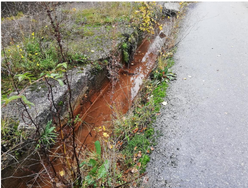
Figura nº83. Canal en la zona de los transformadores de Calderón.
