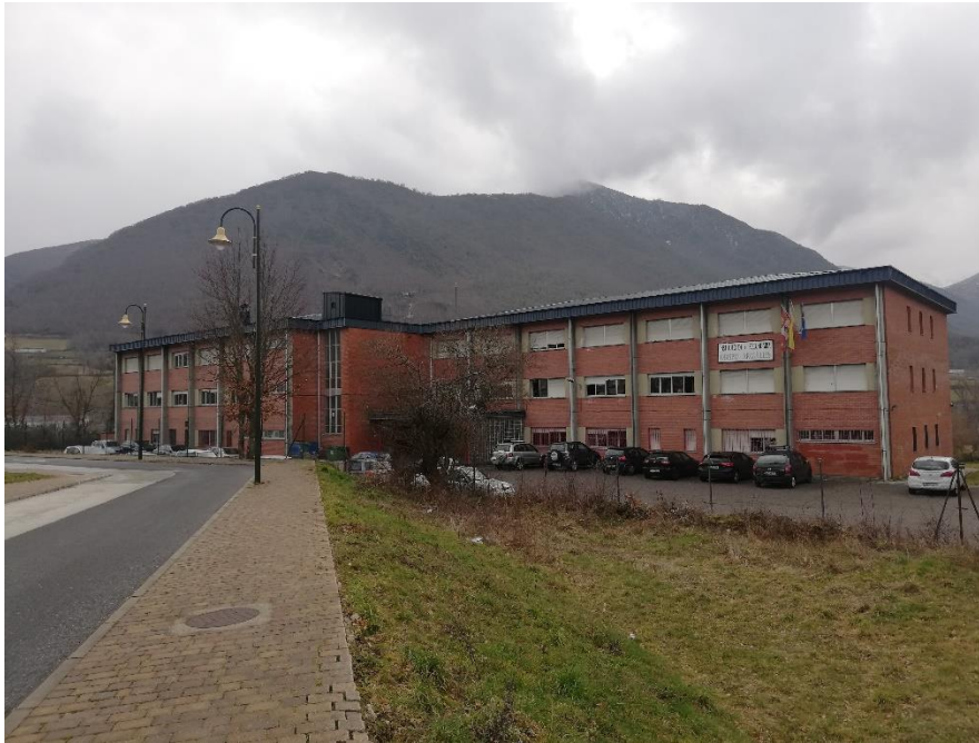
Figura nº59. Edificio principal IES Obispo Argüelles
