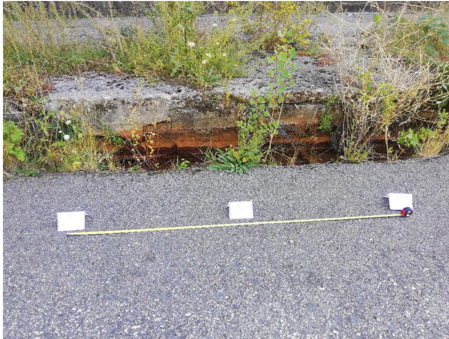
Figura nº80. Delimitación de longitud en canales de la bocamina de Calderón.
