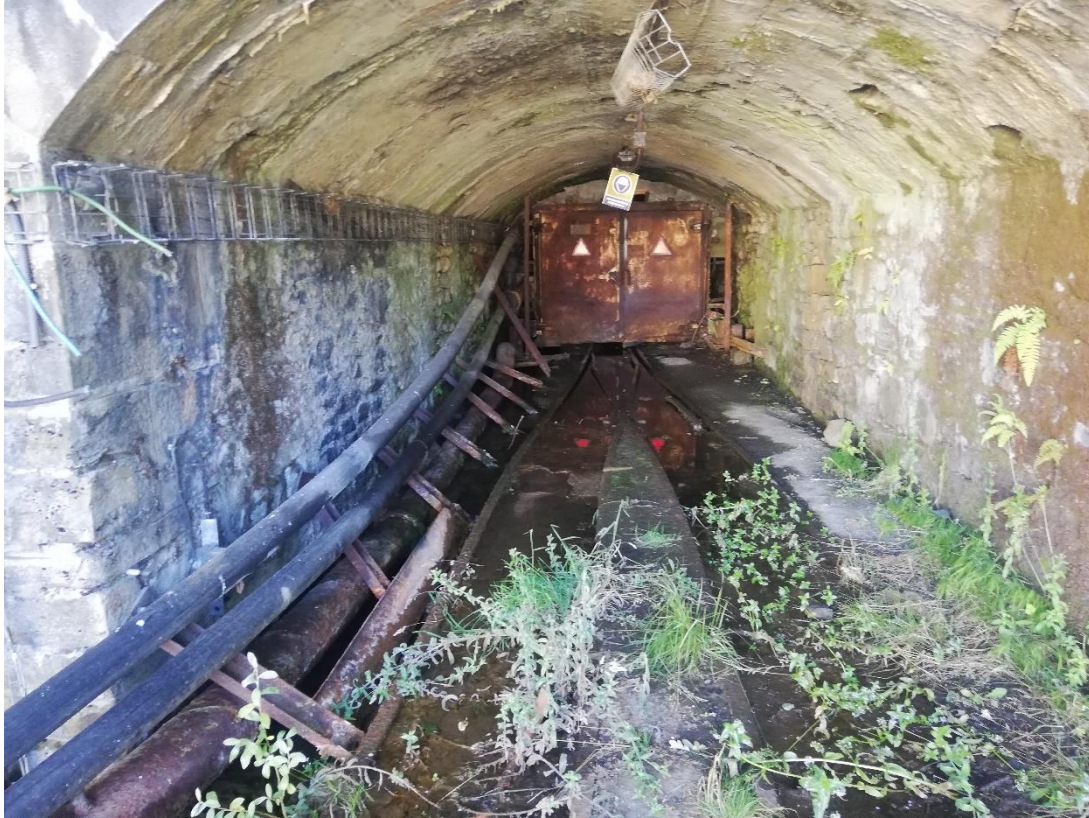
Figura nº82. Bocamina de Calderón con el canal de salida de agua de mina a la izquierda.
