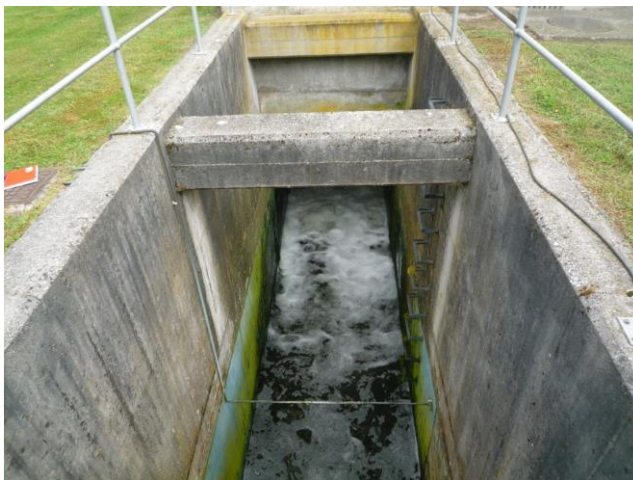
Figura 90. Fotografía del canal de salida de la EDAR elegida. [Fuente: Elaboración propia].
