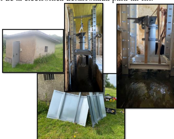
Figura 88. Estructura que alojará la turbina en la ubicación escogida. [Fuente: Elaboración propia].
