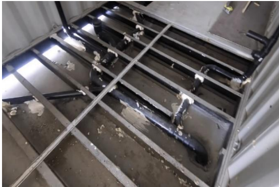
Figura 11.2.-Estructura inferior del contenedor
