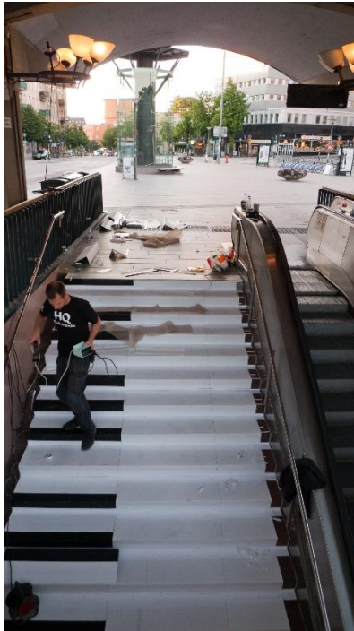
Figura 3.2: Instalación y resultado final de las escaleras – piano en la estación de metro Odenplan en Estocolmo
