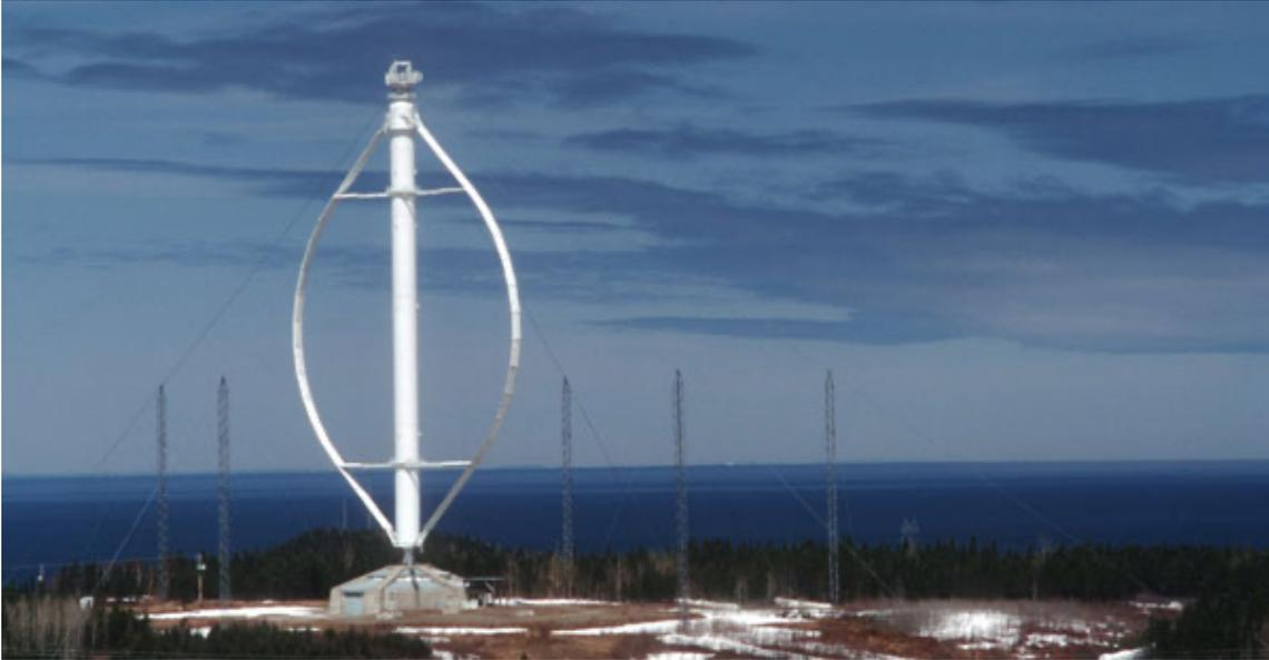
*Ilustración 12. Imagen de un aerogenerador Darrieus [32]*
