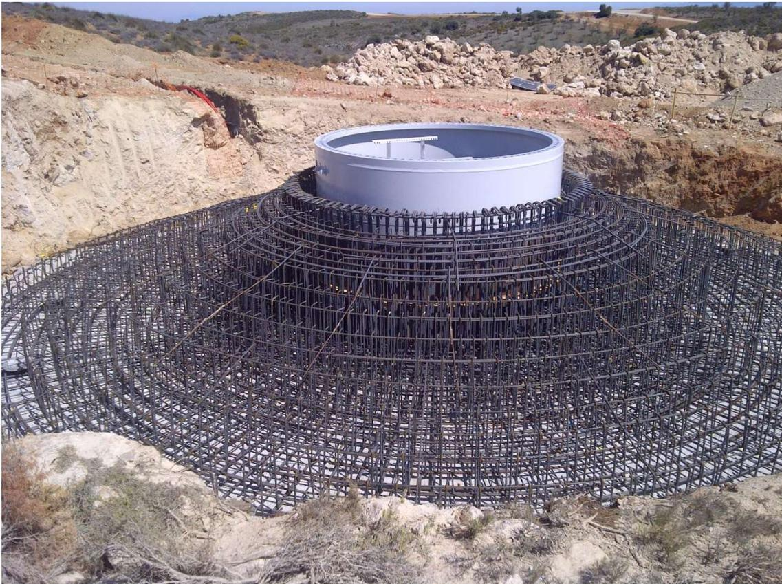
*Ilustración 16: Armadura de una zapata (Enertech, 2015)*
