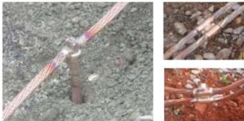
***Ilustración 22: Conexiones de puesta a tierra (Erico, 2012)***
