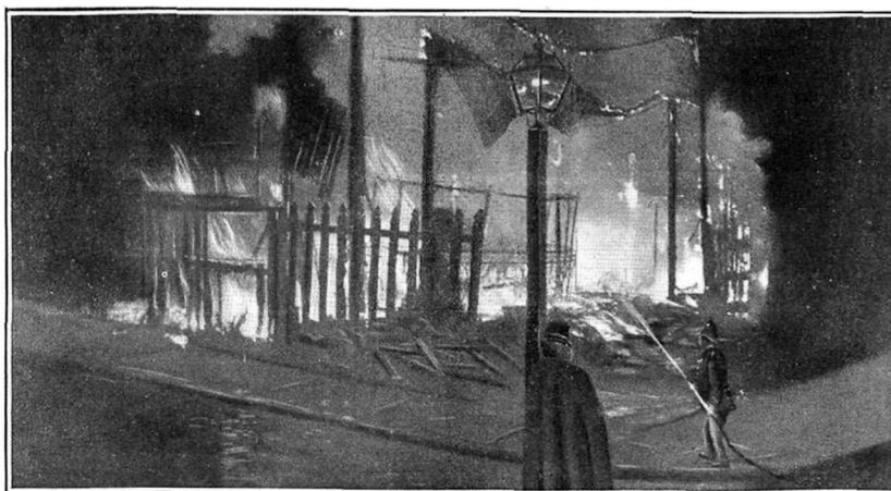
Imagen 35: «Aspecto que ofrecía el cinematógrafo Ena Victoria, establecido en la calle del Pez, de Madrid, durante el incendio que lo destruyó la madrugada del 1 del actual». «Callejeando. El incendio de un "cine"», Nuevo Mundo , año XV, n.º 731, 9-I-1908, p. 22.
