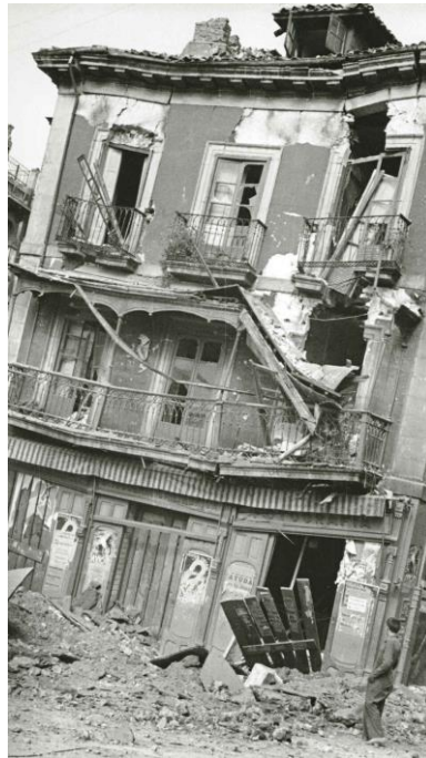
Figura 5.9.: Edificio destruido en la plaza Seis de Agosto, Gijón. Octubre 1.937.
