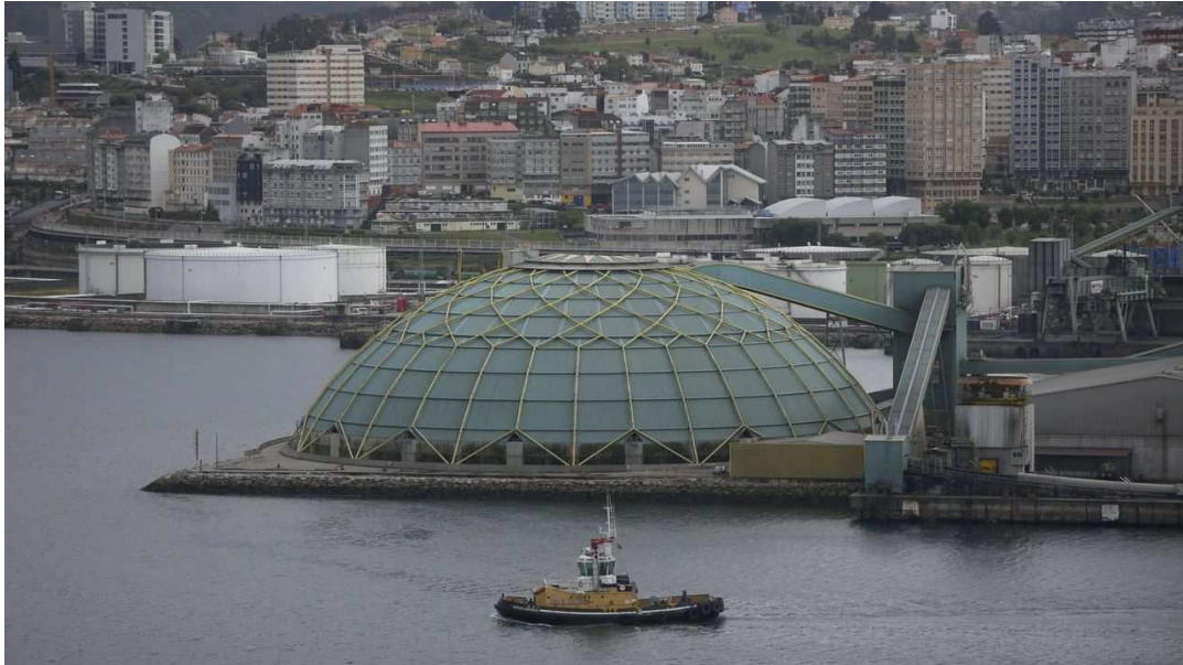
Figura 11. Cúpula para albergar graneles del puerto de La Coruña
