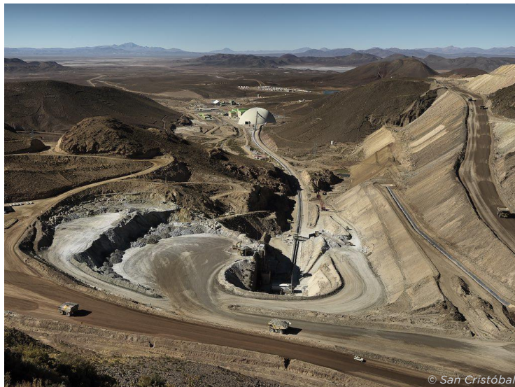
Figura 17. Mina de San Cristóbal (Bolivia)
