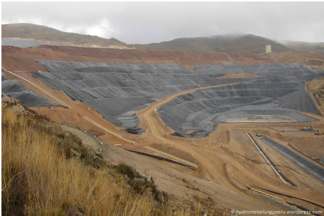
Figura 24. Proceso de lixiviación mediante pilas estáticas ( multi-lift )
