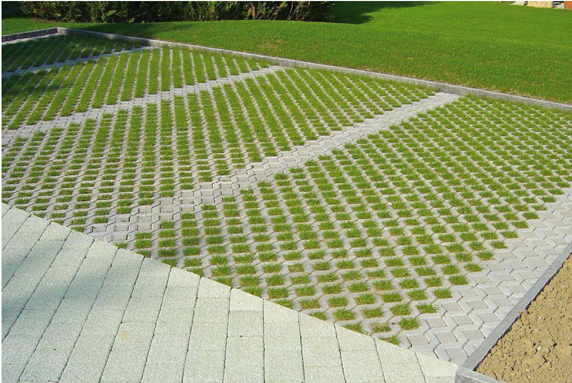
Figura 53. Ejemplo de aplicación Pavimentos permeables (Fuente: Pinterest )
