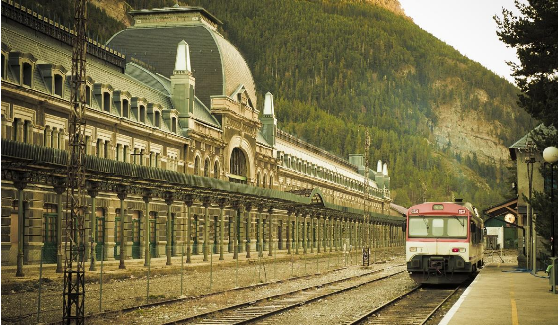
Figura 2. Estación ferroviaria de Canfranc (Fuente: Distrito Castellana Norte Madrid )
