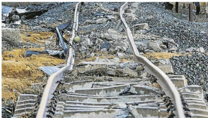
Estado en que quedó la vía del ferrocarril tras el descarrilamiento. - EFE / RAÚL CARO
