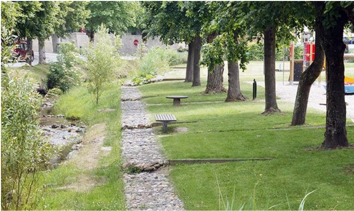
Figura 60. Ejemplo aplicación Zanjas filtrantes (Fuente: Pinterest )
