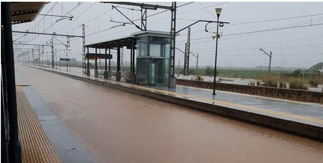
Figura 9. Corte en la línea ferroviaria Castellón-Tarragona a su paso por Vinaròs debida a la gota fría (Fuente: El Periódico Mediterráneo, 2018 )
