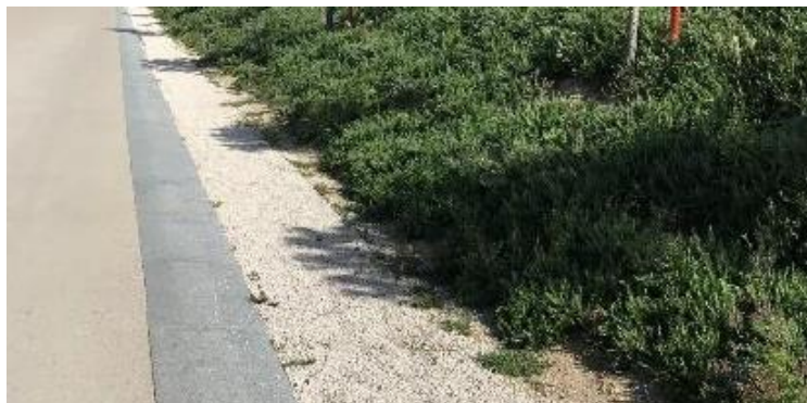
Ilustración 15. Ejemplo de aplicación de dren filtrante en el entorno de Madrid Río.
