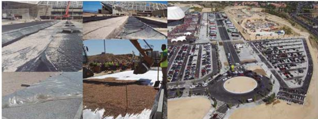
Ilustración 32. Conjunto de actuaciones llevadas a cabo en el entorno del Wanda Metropolitano.
