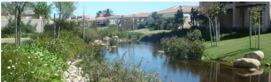
Ilustración 18. Ejemplo de aplicación de depósito de detención.
