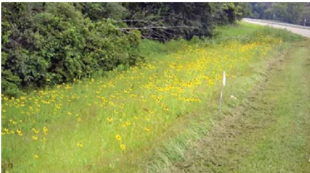
Ilustración 17. Ejemplo de aplicación de franja filtrante.
