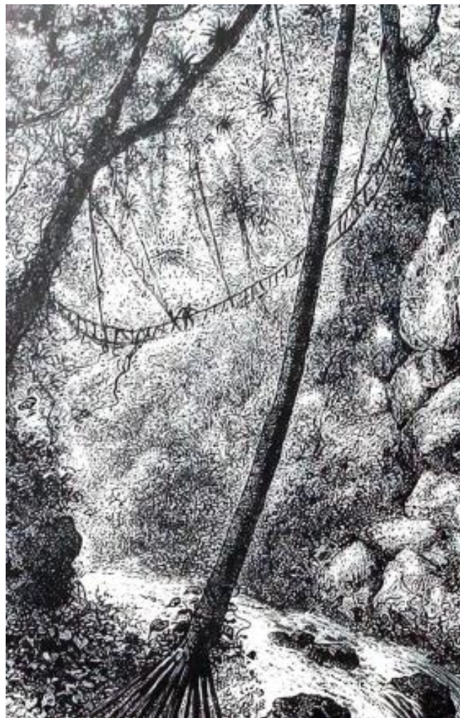
Figura 1. Puente de bejucos, perteneciente a la tipología más primitiva de puentes de hamaca, ya que carece de "padrones" (estribos) anclándose directamente a los troncos de los árboles (González Tascón 1992).
