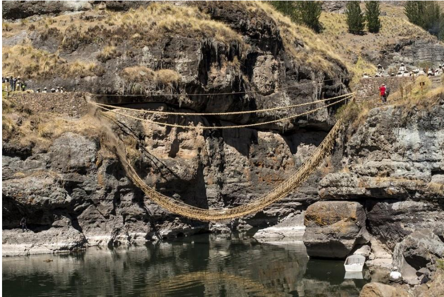
Figura 6. Puente Q'eswachaka antiguo es dejado caer al río para construir el nuevo en su lugar (Busqué 2019).
