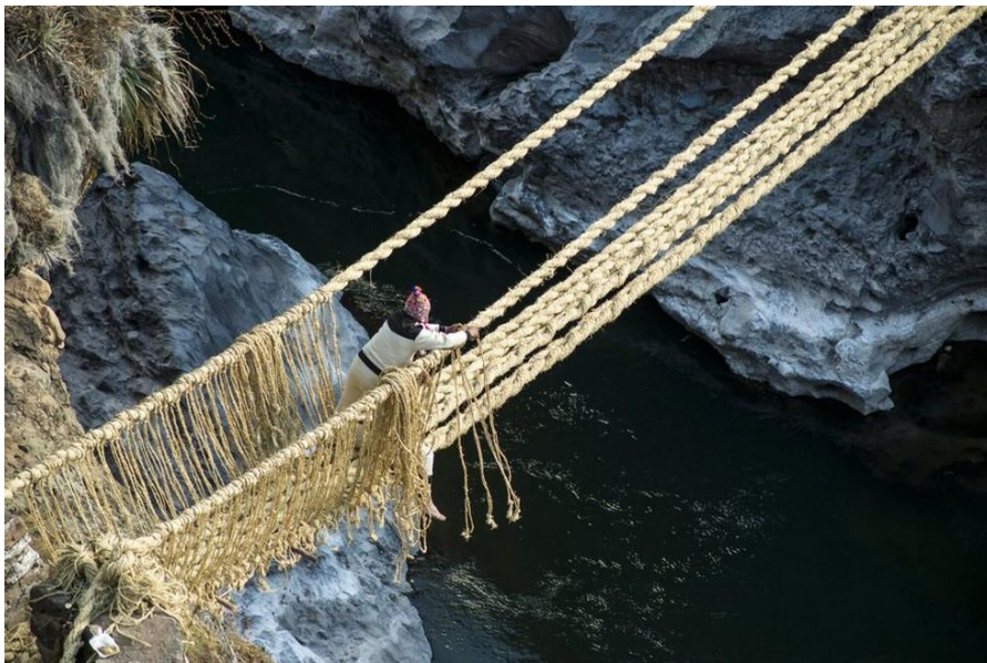
Figura 7. Hombre colocando las soguillas a lo largo del puente (Busqué 2019).
