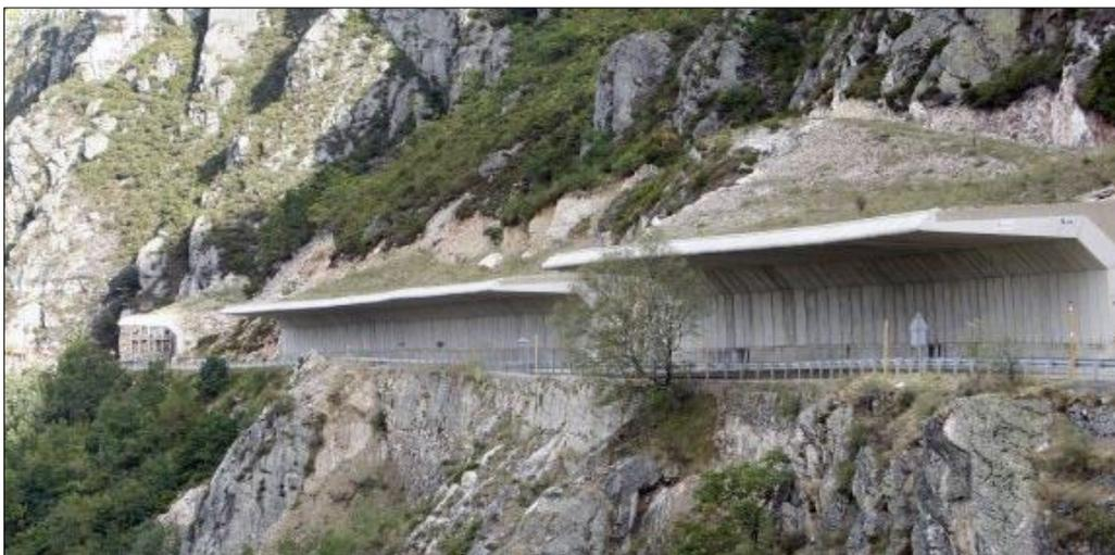
Figura 3-56. Viseras antialudes de hormigón instaladas en una carretera de alta montaña.
