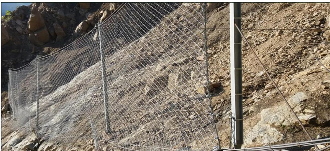
Figura 3-54. Ejemplo de barrera estática compuesta por alambre de acero.
