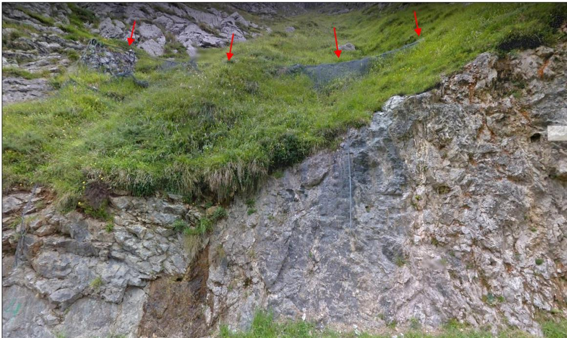
Figura 3-50. Barrera de anillos anclada a la roca recubierta de malla de triple torsión. Destaca su baja altura de 1,5 m aproximadamente cubierta de vegetación.
