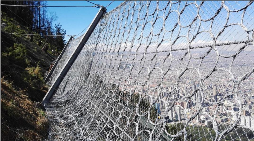
Figura 3-55. Ejemplo de barrera dinámica compuesta de anillos de acero y recubierta de malla de acero.
