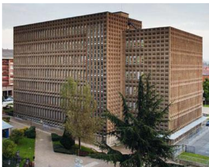
Figura 33. Torre de laboratorios (Fuente: Universidad de Oviedo)
