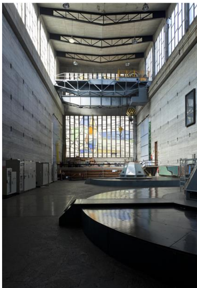
Figura 20. Central hidroeléctrica de Silvón (Fuente: Fundación DOCOMOMO Ibérico)
