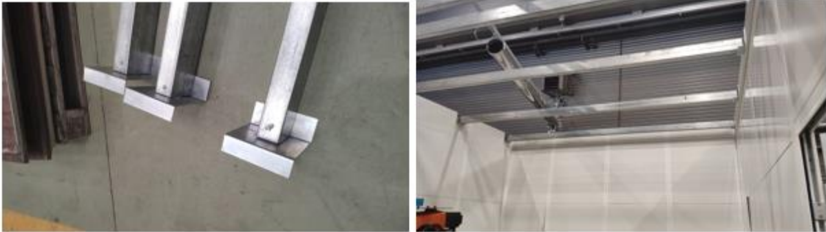
Figura 5. 25 Conjunto de perfiles que forman el techo
