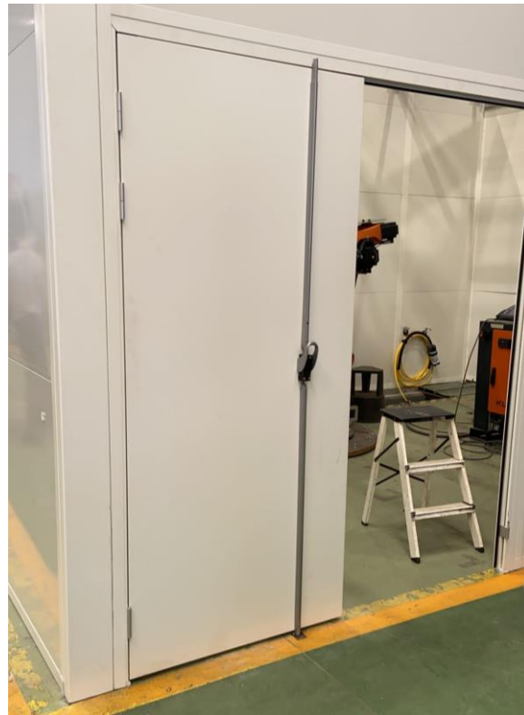
Figura 5. 24 Instalación de las puertas
