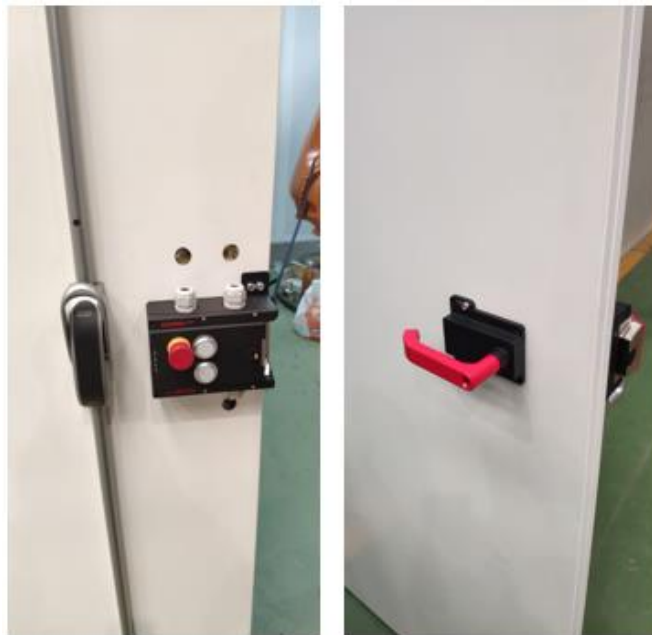
Figura 5. 31 Instalación del cierre de seguridad
