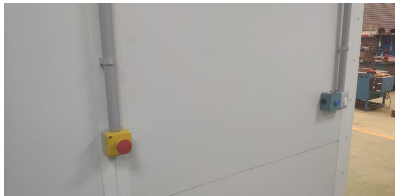
Figura 5. 33 Colocación de la seta de emergencia interior
