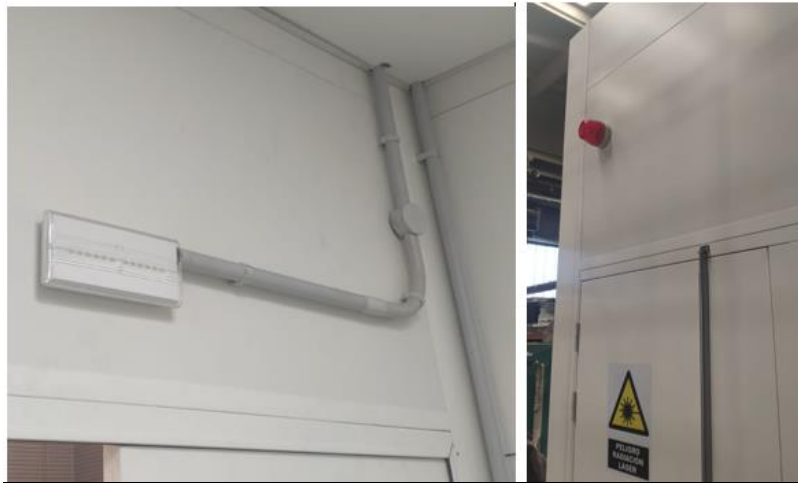
Figura 5. 32 Montaje de la luz de emergencia
