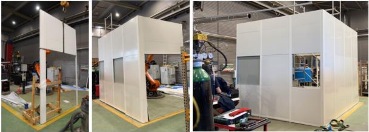
Figura 5. 23 Montaje de la estructura vertical de la cabina
