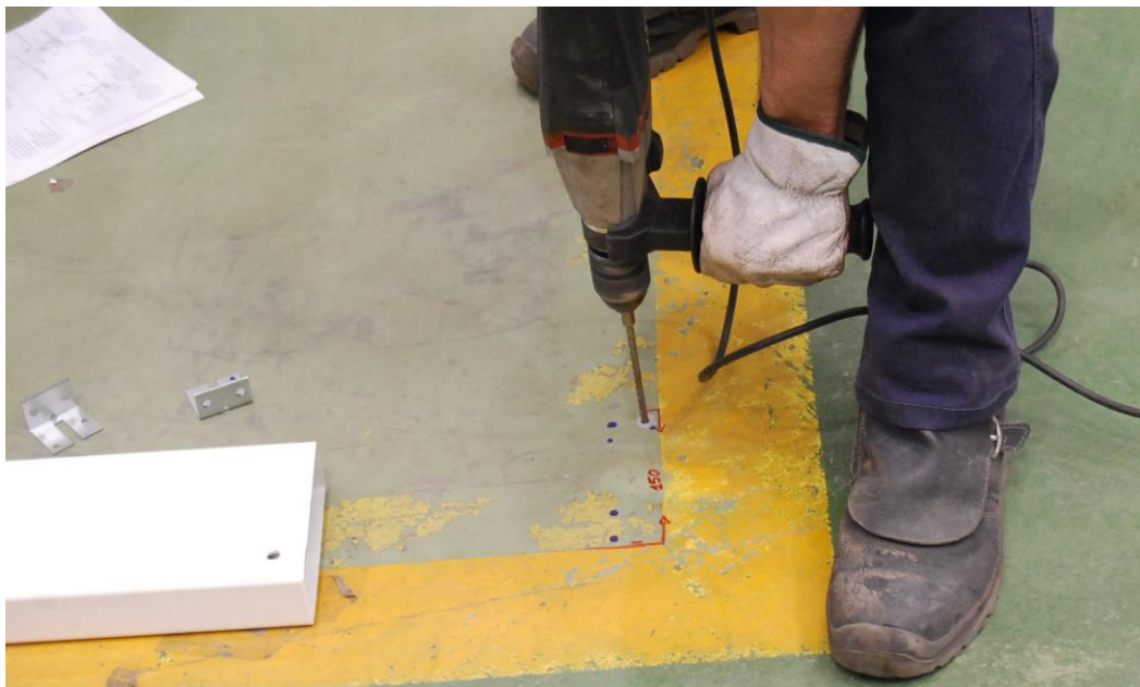
Figura 5. 22 Mecanizado de la zona de construcción
