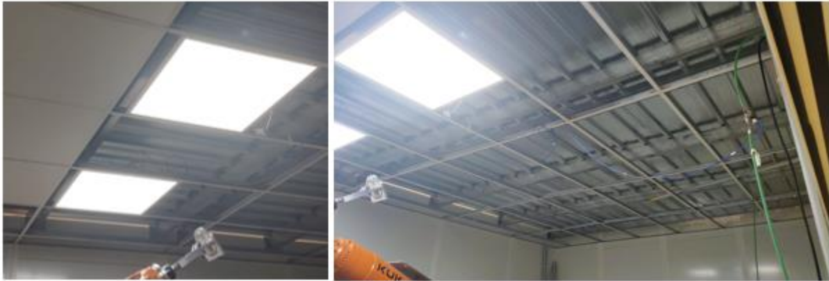
Figura 5. 27 Instalación del falso techo
