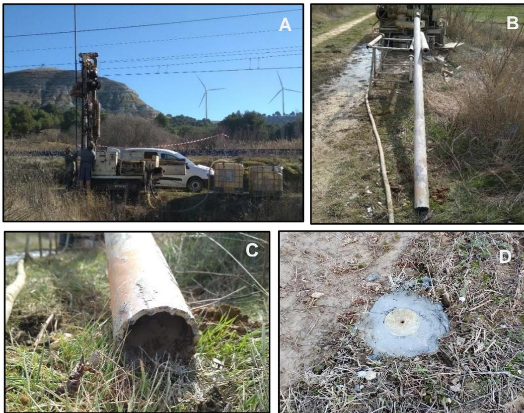
Figura 2.1 A) Sonda montada sobre orugas. B) Batería simple tipo B de 86 mm. C) Corona de widia de 86 mm. D) Arqueta metálica.
