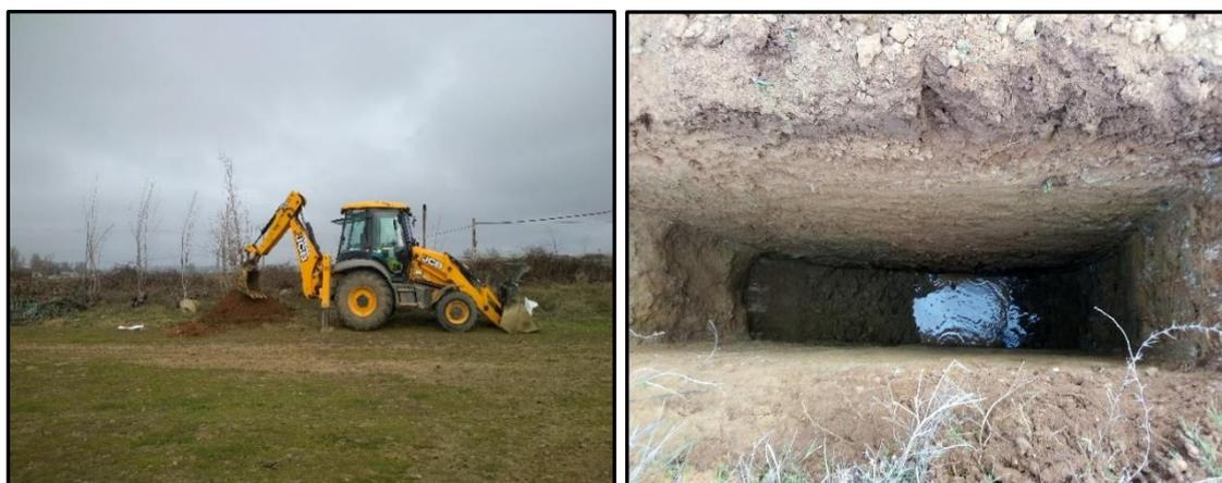
Figura 2.3 En la imagen de la izquierda se observa una retrocargadora ejecutando una calicata. A la derecha, se muestra una calicata de 3 m de profundidad en donde se detecta el nivel freático.
