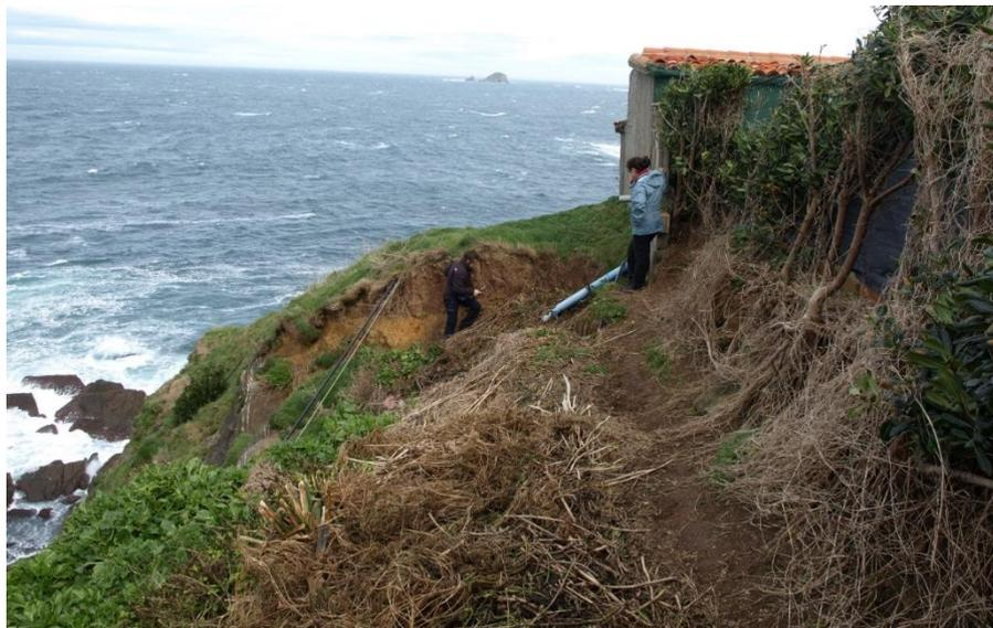
Figura 26: Cicatriz de un movimiento complejo que afecta a una zona edificada del tramo B. Se observa como la masa deslizada ha dejado al descubierto los cables de la red eléctrica (ver situación en Figura 23).
