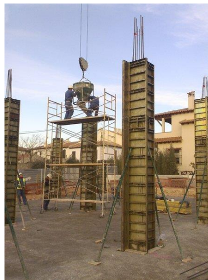
Figura 12. Hormigonado de pilares encofrados. Fuente: Google imágenes.
