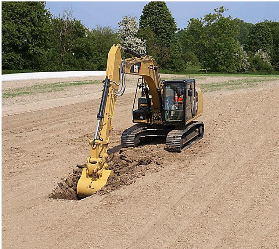
Figura 9. Retroexcavadora para labores de excavación y preparación de explanada. Fuente: www.cat.com .
