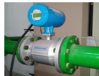
Figura 22 – Detalle del caudalímetro.
