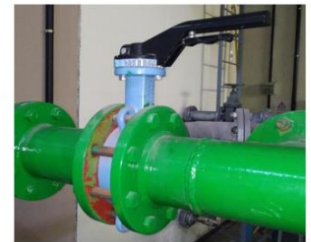
Figura 21 – Detalle de la válvula a la salida de la bomba.
