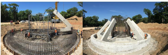
Fig. 23 Zapata circular prefabricada (esteyco)
