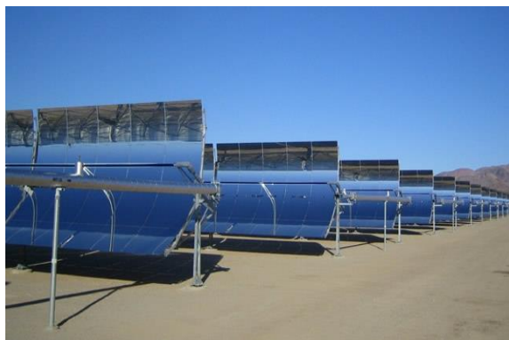
Imagen 1.5 Concentrador solar cilíndrico parabólico (Villasante, 2010)
