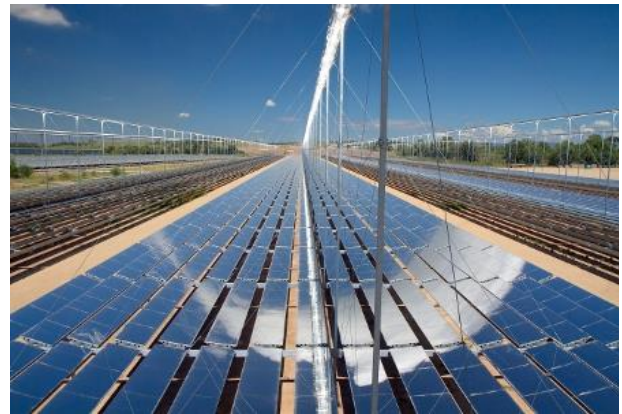
Imagen 1.4 Central de termosolar de espejos reflectores Fresnel (Helionoticias, 2012)
