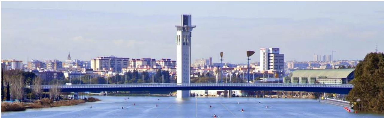
Figura 6. Puente de La Cartuja: vista sobre el Río Guadalquivir del vano principal (central) y parte del vano lado Sevilla
