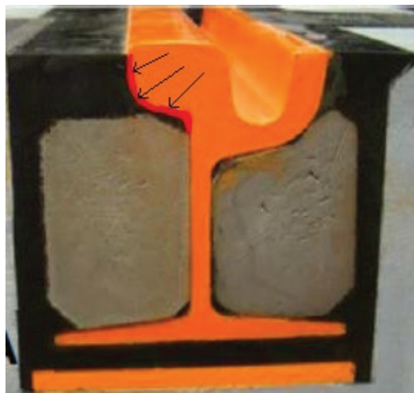
FIGURA 2. Ejemplo de la región sensible a la temperatura de un embebido polimérico en un carril de tranvía.
