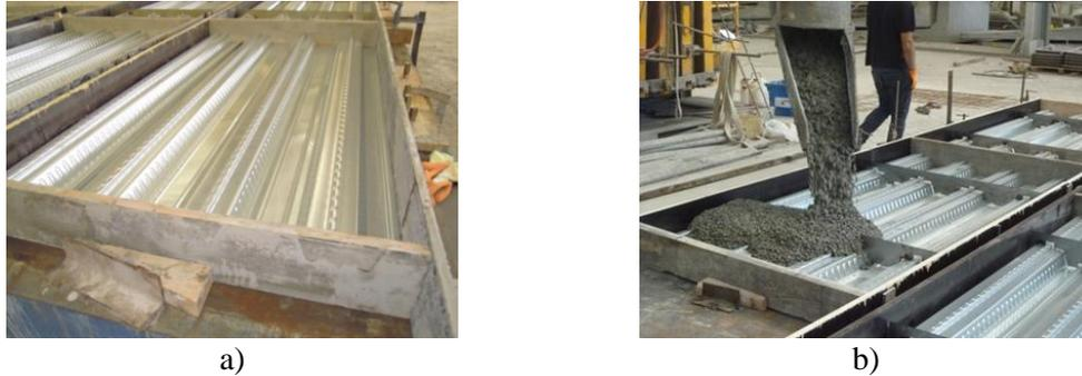
Fig 20. Fabricación de los forjados mixtos: a) Encofrado de la losa mixta; b) Vertido del hormigón.
