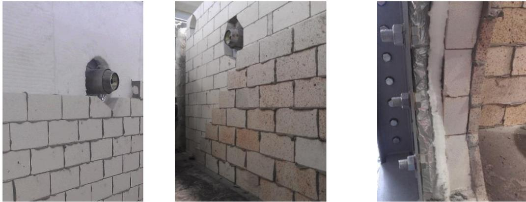
Fig 51. Construcción y composición de las paredes del interior de la cámara de combustión.
