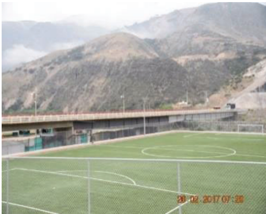
Puente sobre el río Chota
