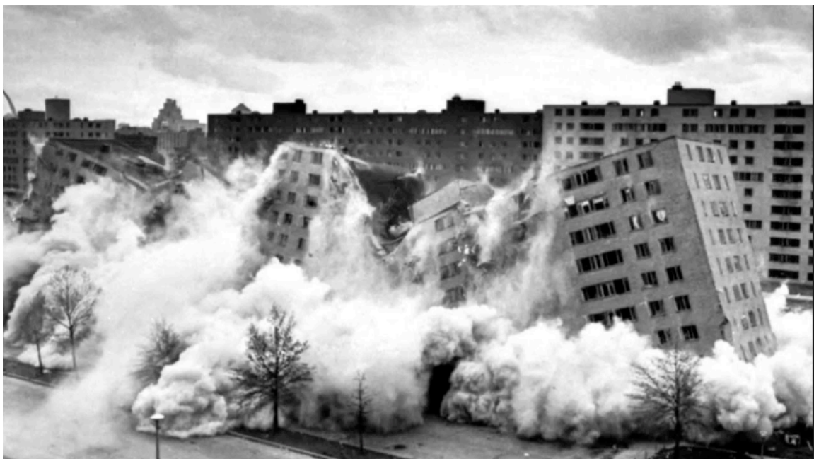
Ilustración 59. Demolición del complejo de edificios Pruitt-Igoe, Missouri. Imagen tomada del documental
