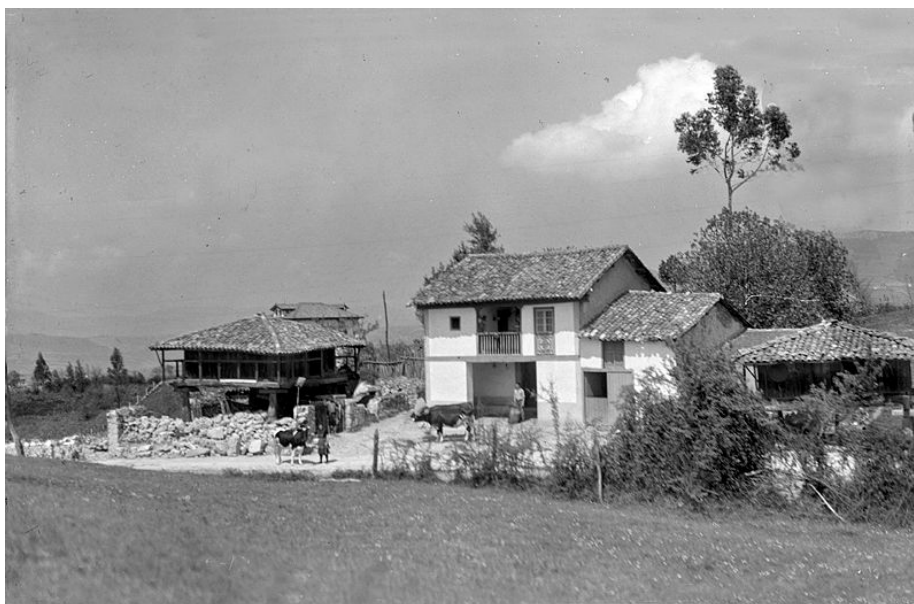
Figs. 4 y 5. Casa en Novellana (Cuideiru), ca. 1919 (Fuente: Florentino Martínez Torner, Las construcciones rurales de Asturias , 1919 76 ). Casa tradicional asturiana. Tarjeta postal de Ediciones Alarde, 1960 (Fuente: Muséu del Pueblu d'Asturies). En ambos casos, viviendas de dos plantas, con corredor y galería, revocadas y con ventanales.
