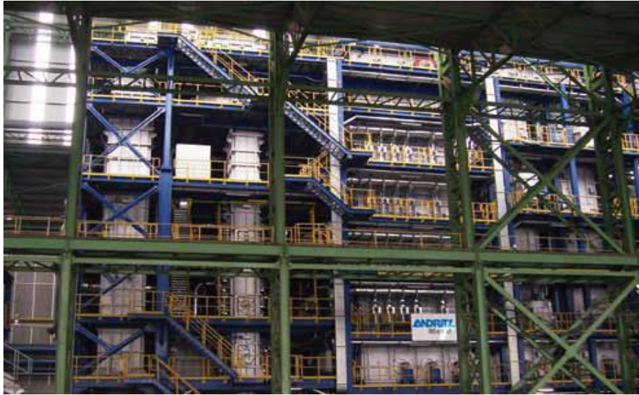
Figura 12 Horno vertical de tubos radiantes
