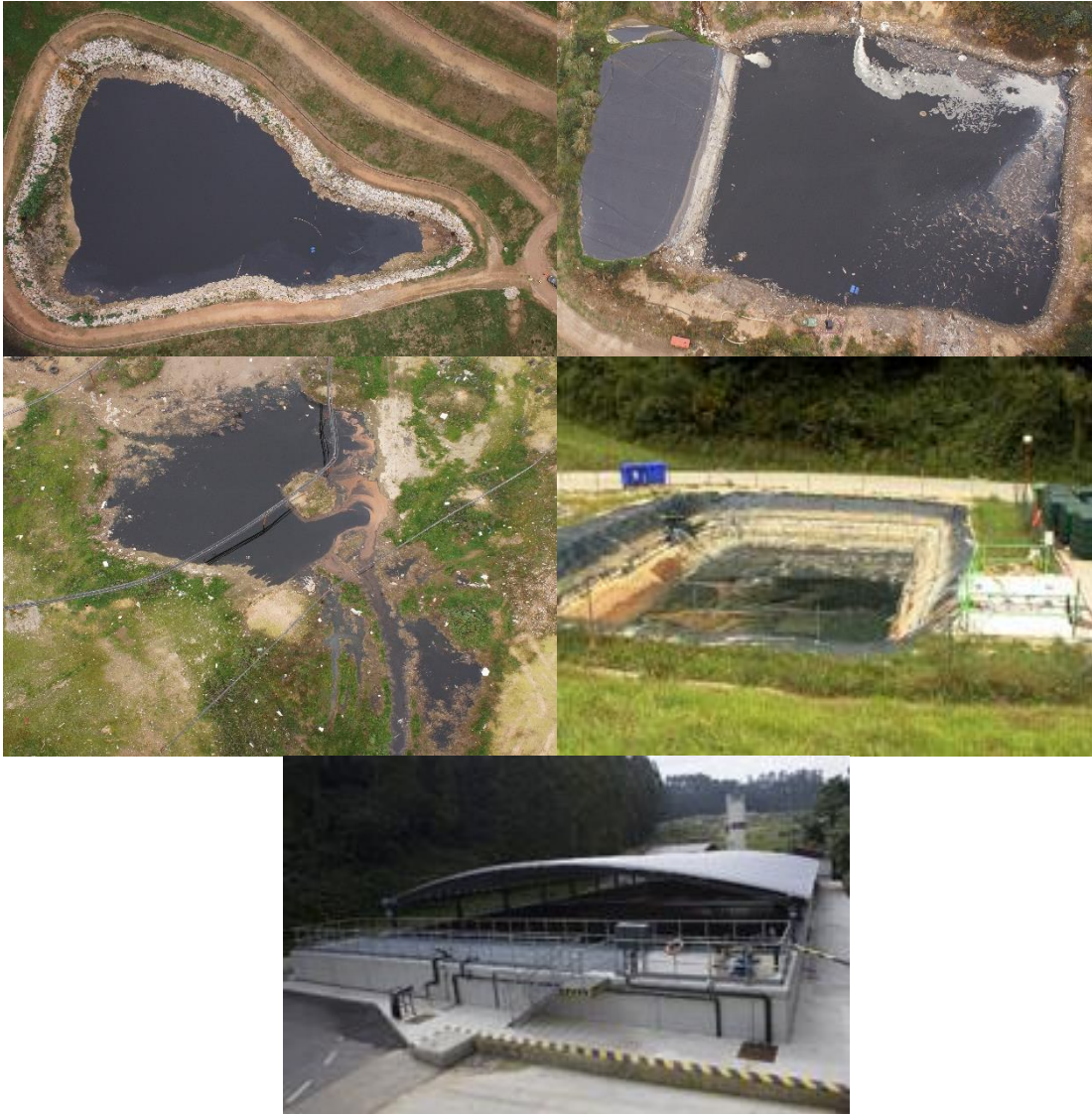
Figura 2.3. Estanques y balsas del sistema de recolección y almacenamiento del lixiviado. Fuente COGERSA.
