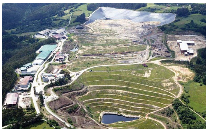
Figura 2.1 Panorámica de la planta de tratamiento RSU COGERSA. Tomado de https://www.lavozdeasturias.es/noticia/oviedo/2018/06/11/ampliacion-vertedero-residuos-peligrosos-cogersa-costara-907315-euros/00031528728228502139607.htm
