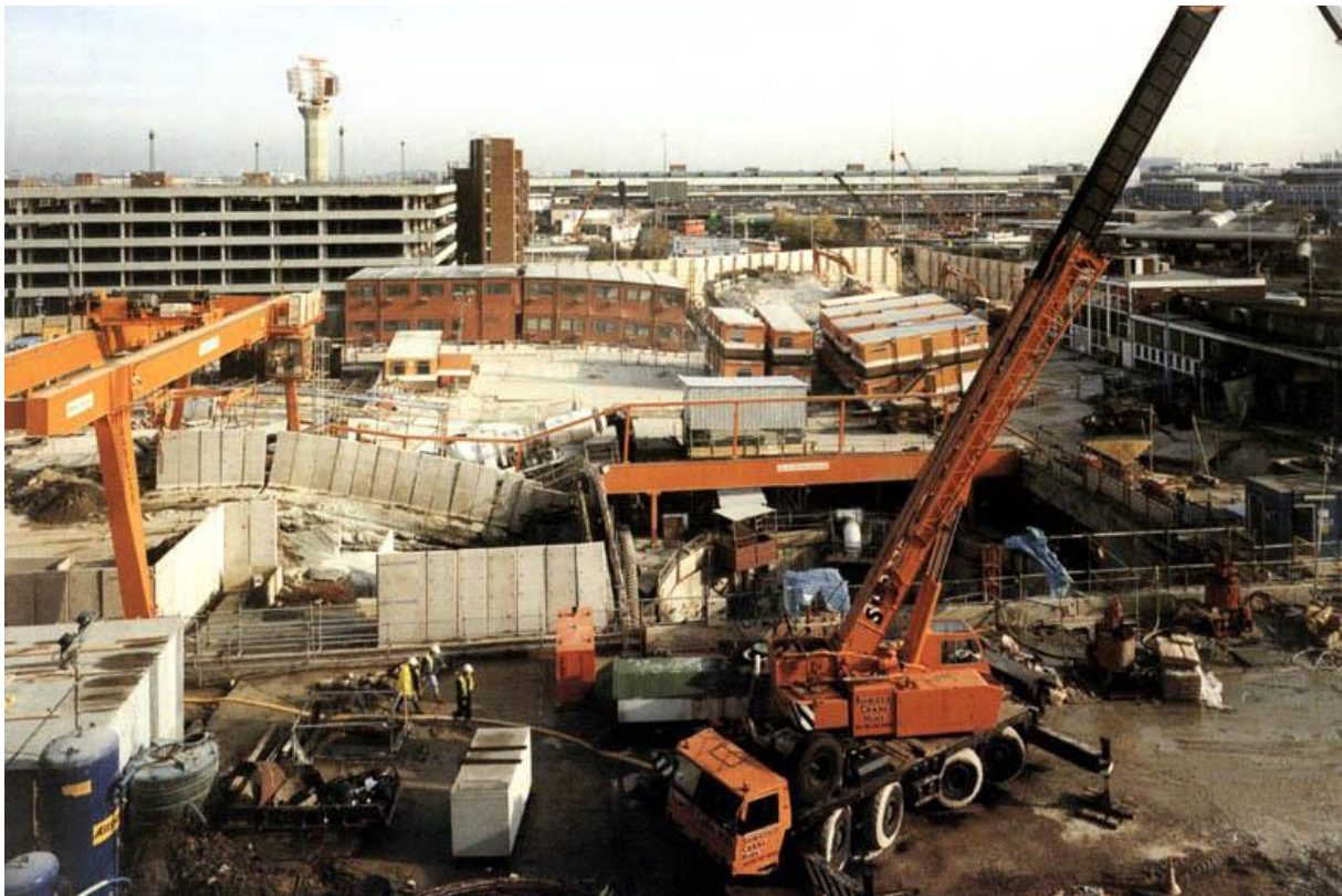
Figura 6.- Efectos en superficie del colapso de los túneles de Heathrow. Tomado de Jones (2000).
