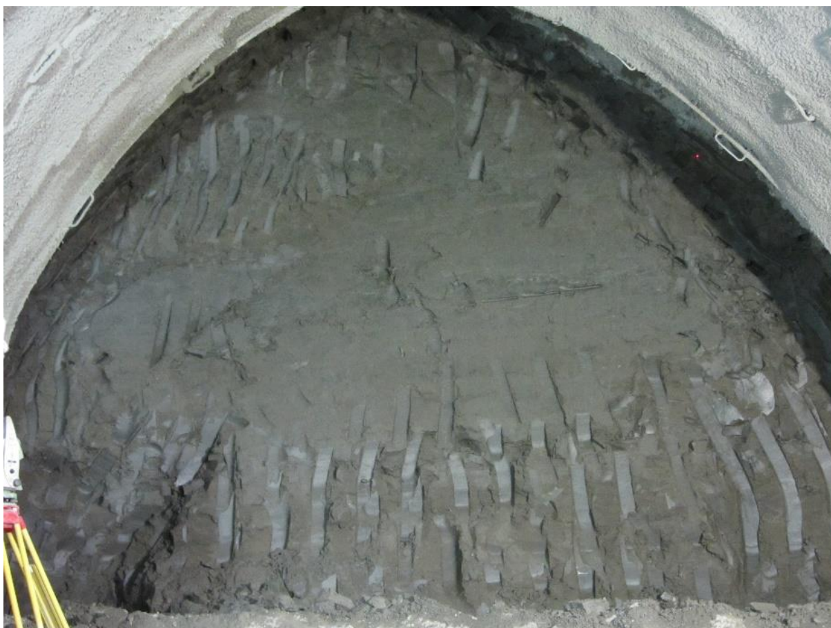
Figura 18.- Aspecto del frente de excavación de un túnel en las Arcillas de Londres (división B). En el frente se puede observar una discontinuidad subvertical buzando hacia el observador. Fuente: Autor.
