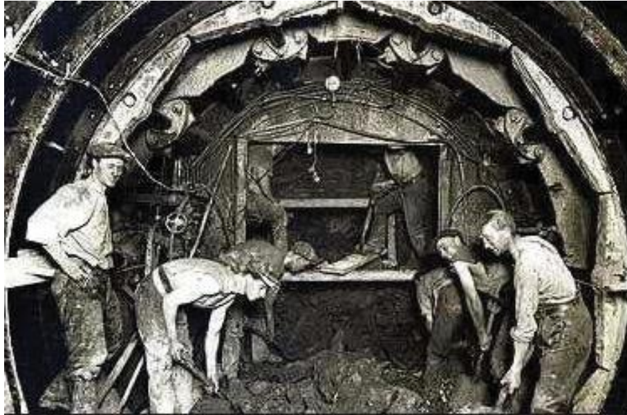
Figura 4.- Aspecto de la excavación del túnel de Rotherhithe usando un escudo tipo Greathead y segmentos de hierro fundido en la estación de Bank. Tomado de Diamond y Kassel (2018).
