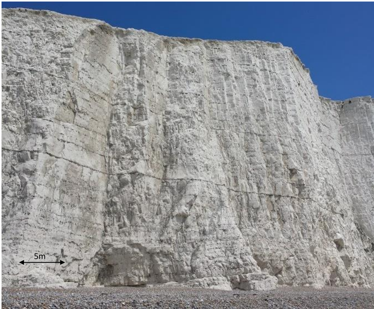
Figura 12.- Aspecto de un afloramiento de Chalk en la costa del Sureste de Inglaterra con los niveles de nódulos silíceos ( flint ) paralelos a estratificación subhorizontal.
