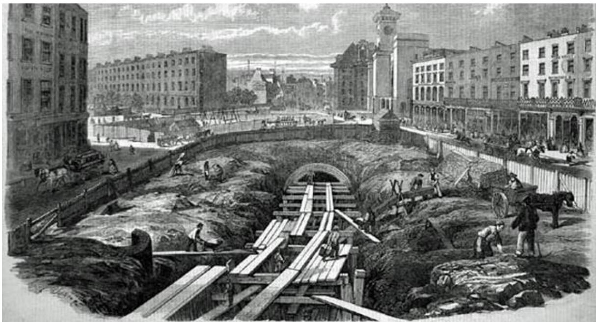
Figura 2.- Ilustración de la excavación de una trinchera cerca de Kings Cross para la construcción mediante el método de “ cut and cover ” de la Línea Metropolitana, la primera línea de metro subterránea del mundo. Tomado de Building the London Underground (2016).
