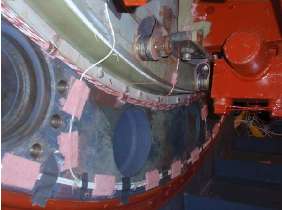
Figura 73 Instalación de sensores de fibra en un generador de potencia
