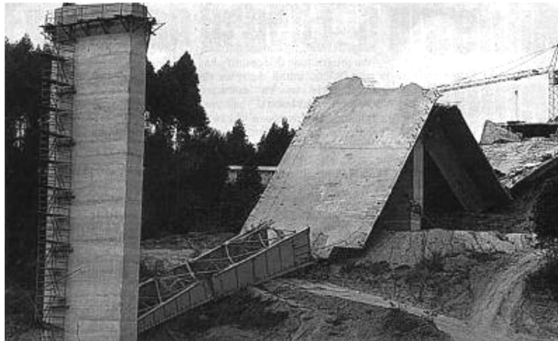
Figura 2 Derrumbe de puente debido a fallo estructural
