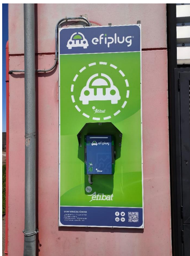
Figura. 30 Ejemplo de instalación exterior montado sobre pared
