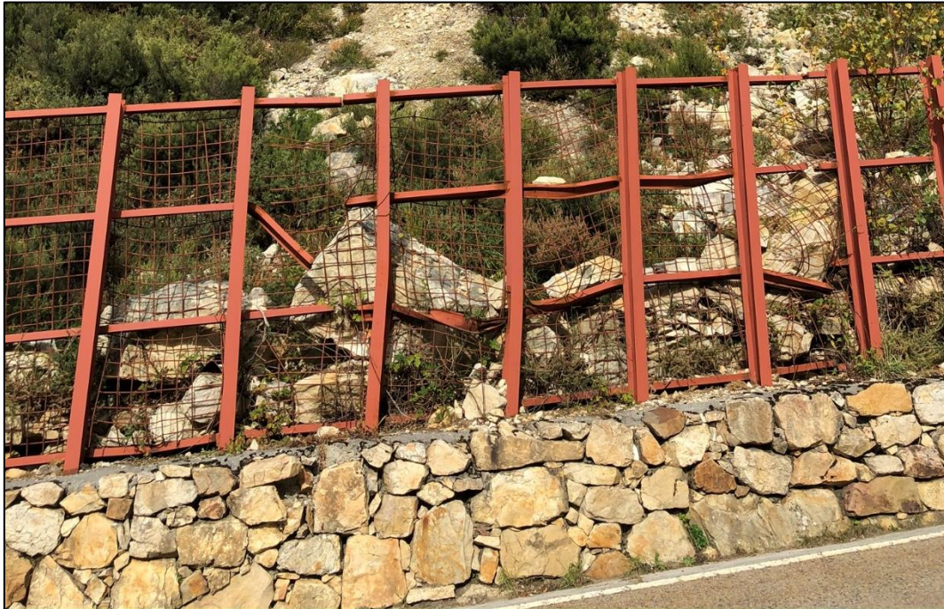
FIGURA 51: ASPECTO DE LA MALLA RÍGIDA Nº 13 CON EVIDENCIAS DE IMPACTOS EN EL PK 20,330 (ALTURA DE LA BARRERA = 3 M).
