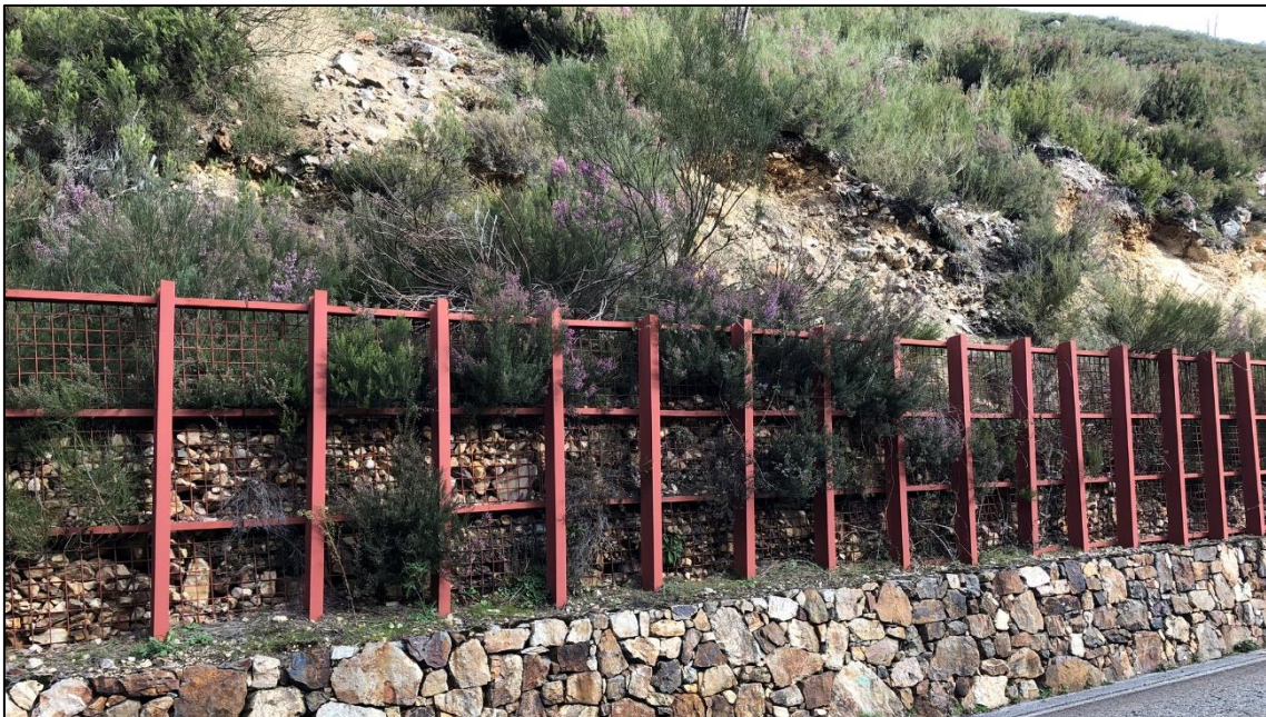
FIGURA 50: MATERIAL RETENIDO POR LA MALLA RÍGIDA 4 EN EL PK 17,200 (ALTURA DE LA BARRERA = 3 M).
