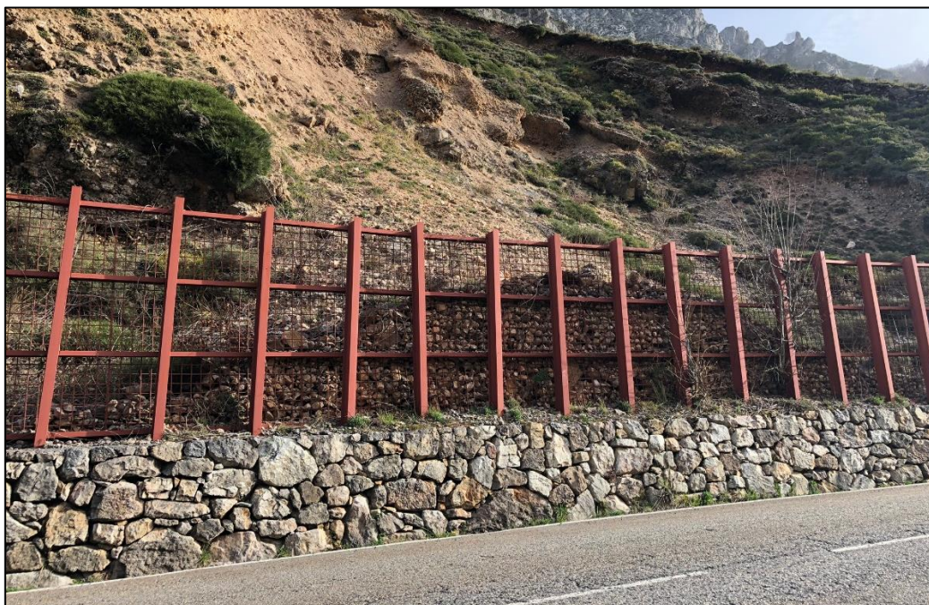
FIGURA 48: MALLA RÍGIDA 1 CONTENIENDO MATERIAL DESLIZADO EN EL PK 16 (ALTURA DE LA BARRERA = 3 M).
