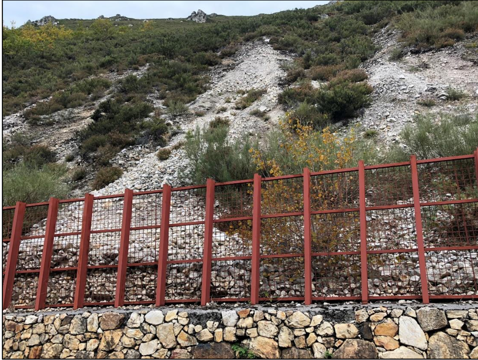
FIGURA 49: MALLA RÍGIDA 5 CONTENIENDO MATERIAL DESLIZADO EN EL PK 17,500 (ALTURA DE LA BARRERA = 3 M).
