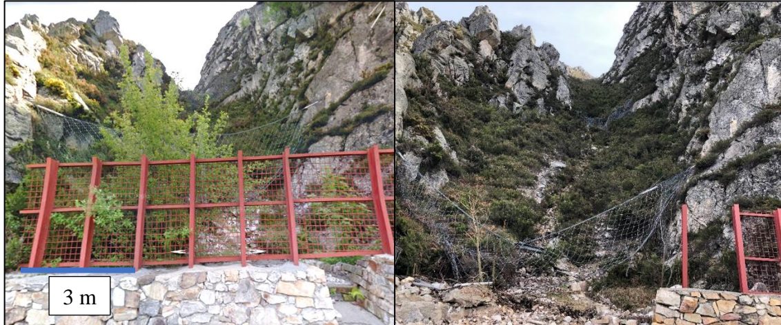
FIGURA 44: ASPECTO DE LA BARRERA RÍGIDA Y DE LAS MALLAS DINÁMICAS ANTES (IZQUIERDA) Y DESPUÉS (DERECHA) DE UN ALUD OCURRIDO EN EL PK 20,960.
