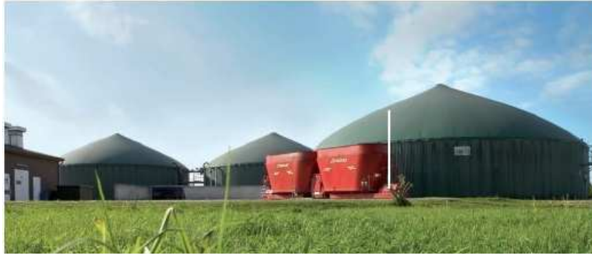
Figura 7. Digestores de una planta de biogás. Fuente: Bentec
