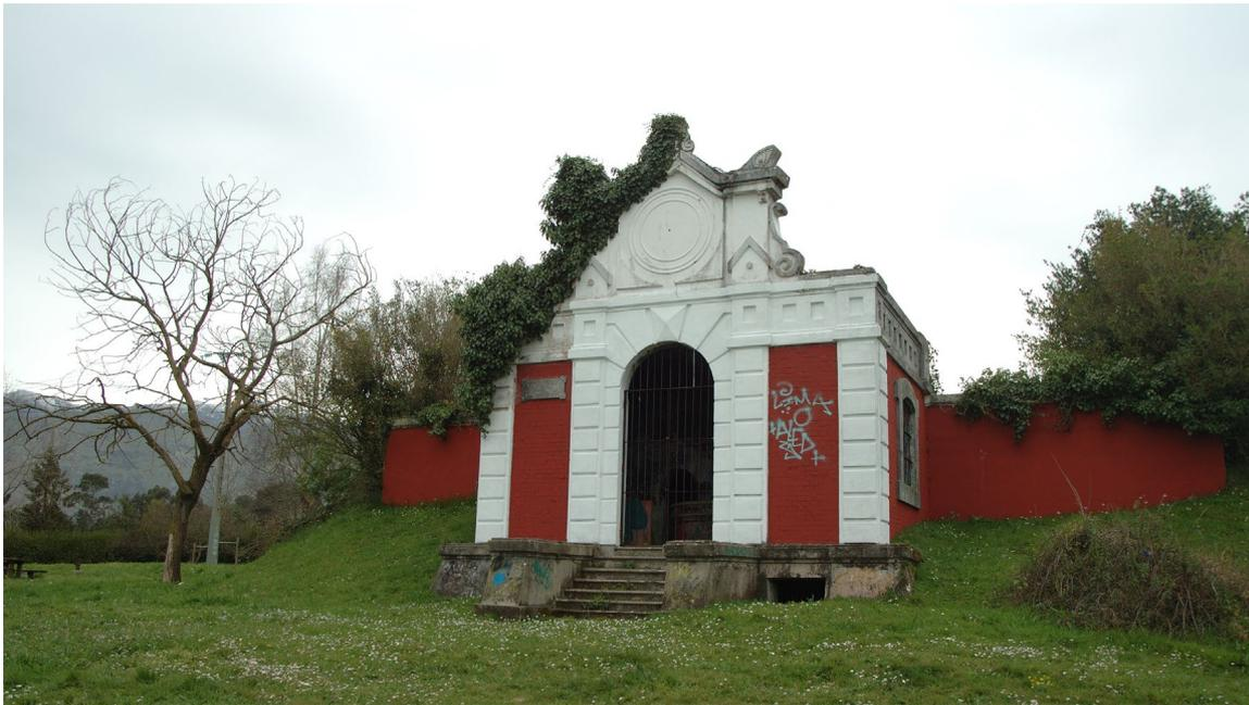
Ilustración 4. Depósito de aguas de Tieves, Llanes. Fachada principal de la cámara de llaves. Ejemplo de aplicación temprana de hormigón armado sistema Hennebique en colaboración con el arquitecto Mauricio Jalvo. 1897. Fotografía de la autora.
