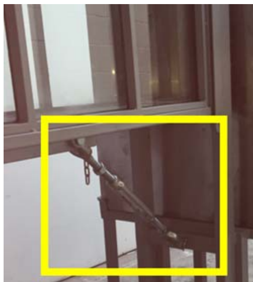
Fig.98 Sistema de variación de pendiente con tornillo y rótula
