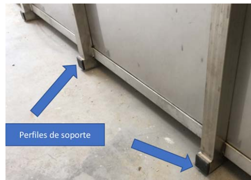
Fig.91 Detalle de perfiles cuadrangulares en solera
