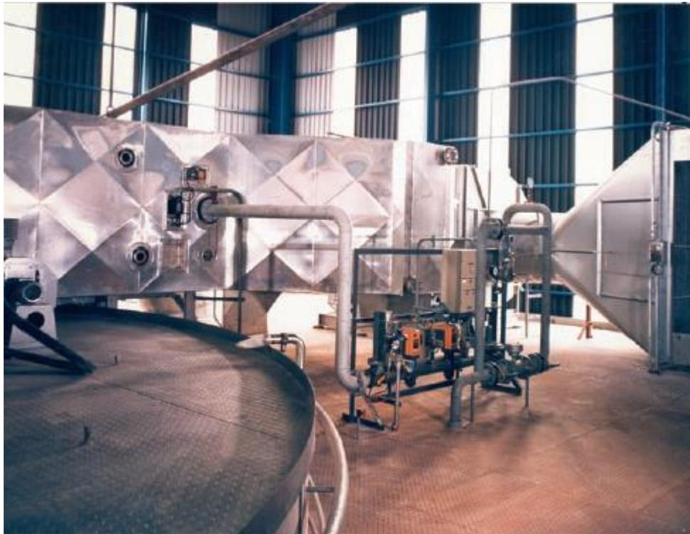
**Figura 5. Vista de un intercambiador para el calentamiento del aire.**
